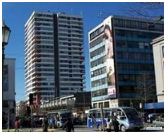
Figura 1: Imagen Edificios con sistemas de ascensores como transporte vertical. Fuente: Internet.
