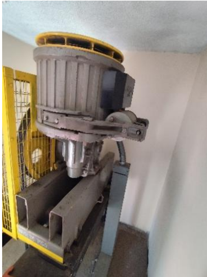
Figura 26: Imagen Motor Otis 14 VTR de 2 Velocidades. Fuente: Elaboración Propia.
