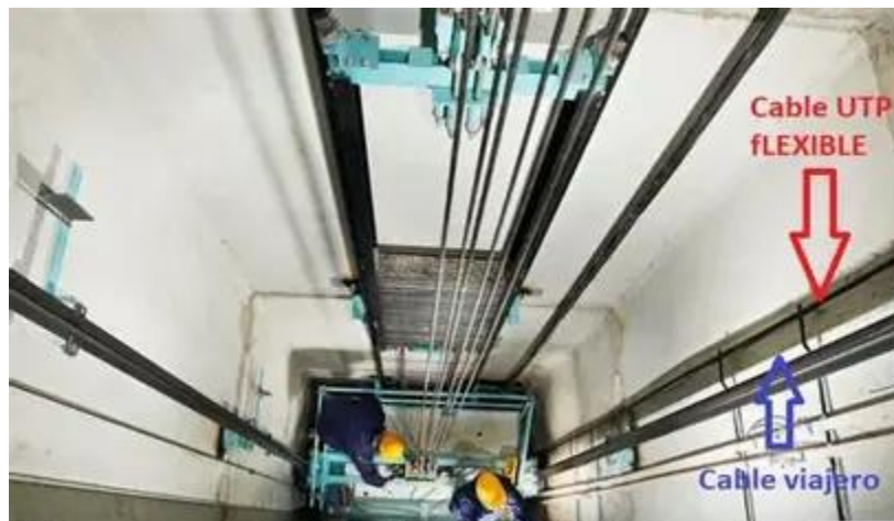
Figura 10: Imagen Cables de Acero "Tracción". Fuente: Internet.
