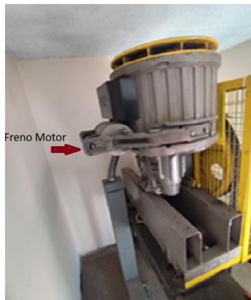
Figura 12: Imagen Motor con Freno Electromagnético. Fuente: Elaboración Propia.
