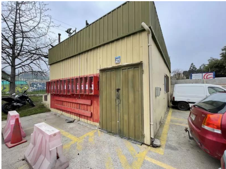
Figura 1-3. Vista frontal instalaciones 1 norte, camino troncal
