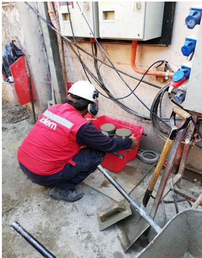
Fuente: Obra edificio 10 norte
