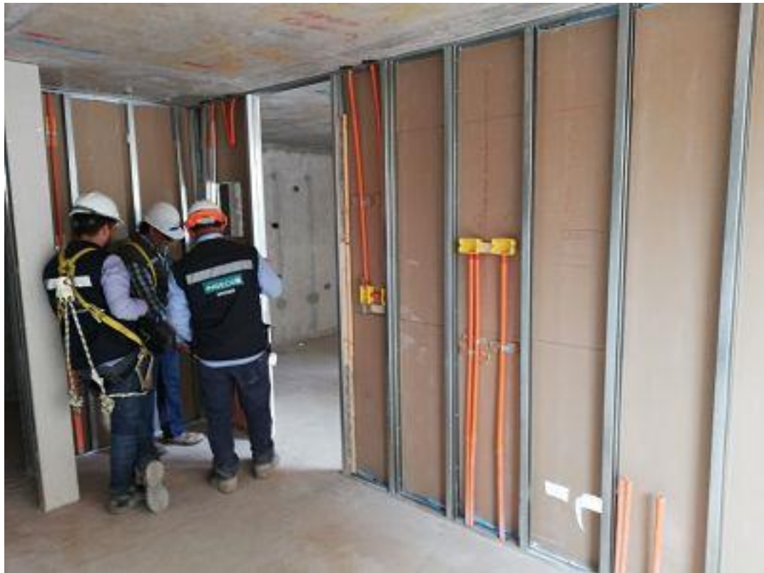
Fuente: Edificio Obra 10 Norte Figura 2.18: Revisión de tabiquería
