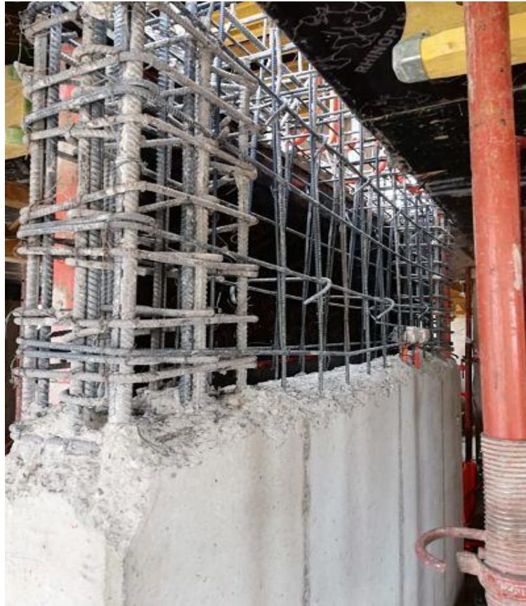
Fuente: Obra Edificio 10 norte
