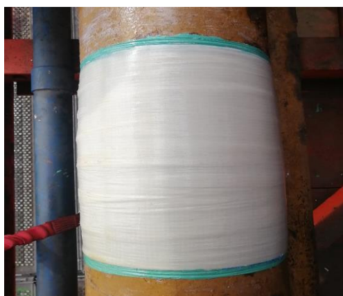
Figura 2.2 Reparación de Pitting, esquema SYNTHO GLASS XT.
