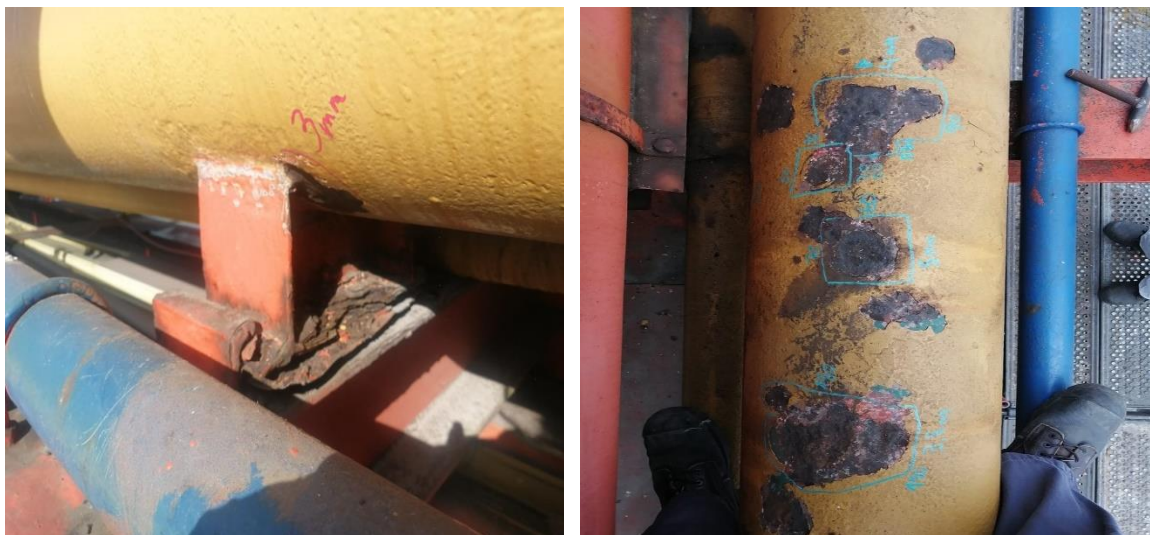
Figura 1.4 Corrosión general en cuerpo cañería 12".
