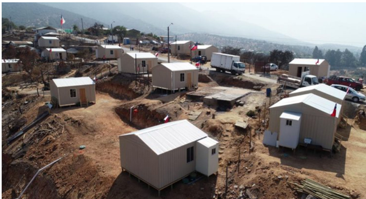
Figura 1.3: Construcción casas emergencia
