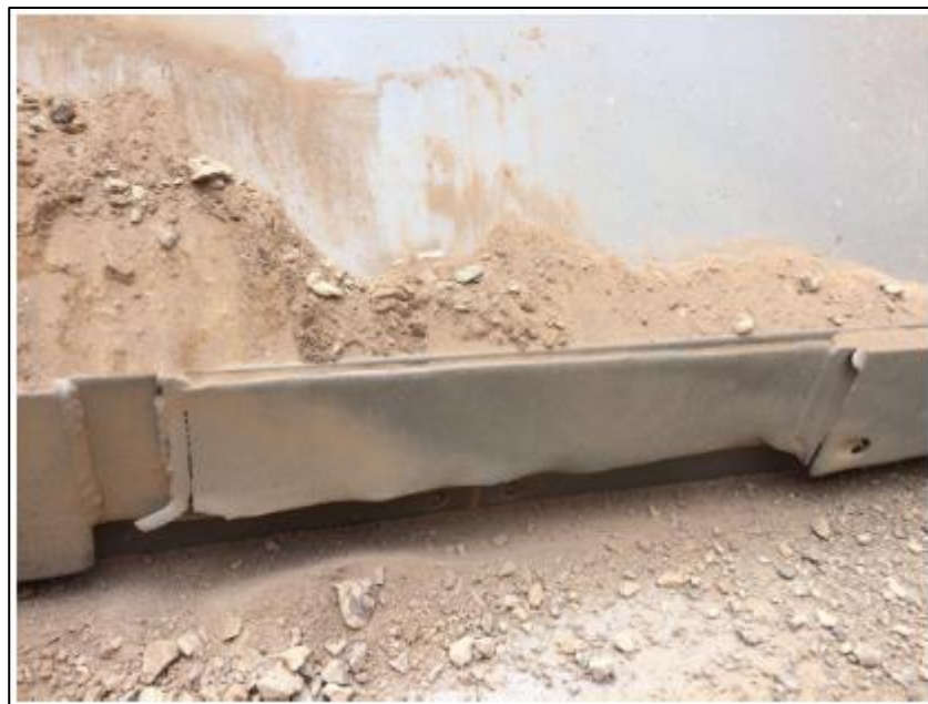
Figura 2-13 Cámara de chancado (2)
