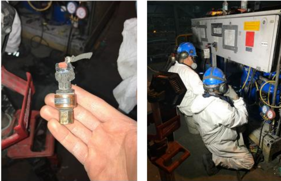
Figura 3-16: Presostato y mantención a Chiller
