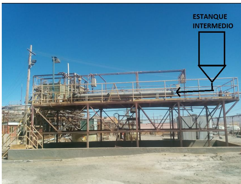
Figura 34: Fotografía donde se indica posición del estanque intermedio de ácido usado (en Boilling Tube).
