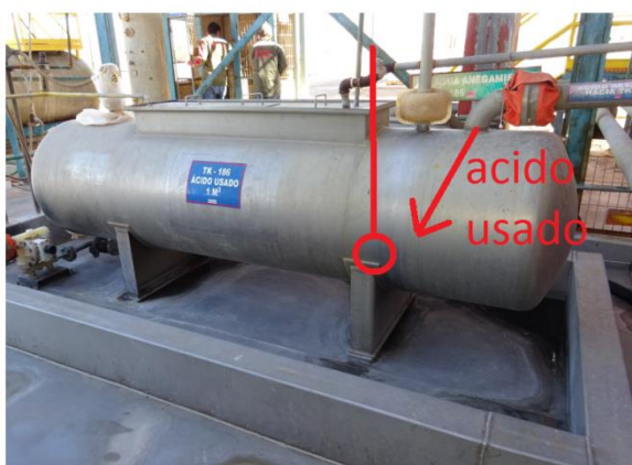
Figura 31: Fotografía donde se indica posición del sensor para el control de temperatura redundante en estanque de ácido débil.
