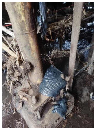
Figura 17: Fuga de lubricante por rotura de línea en unidad central de lubricación (Fuente: Fotografía propia)
