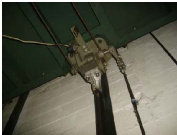
Figura N° 9: Paracaídas, seminario CDT "Diseño y compra de ascensores".
