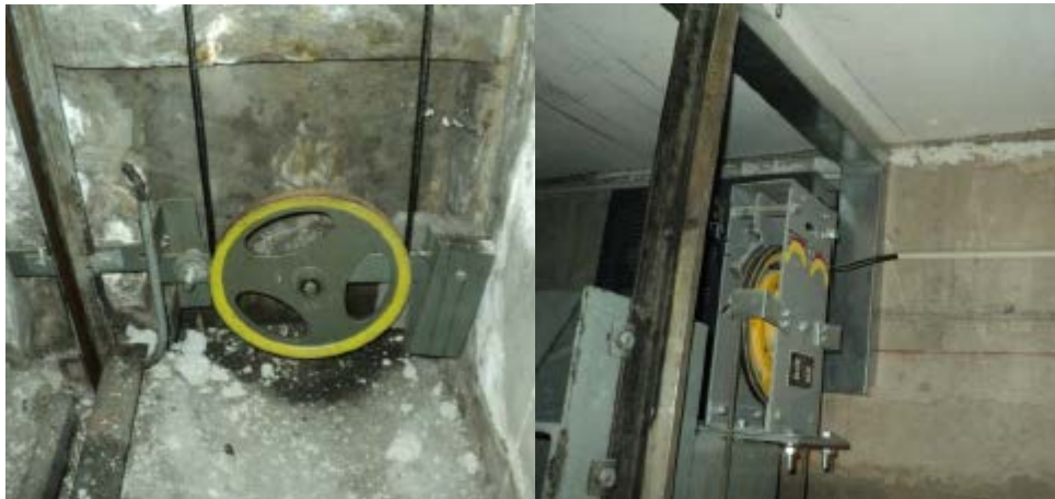
Figura N° 10: Polea tensora, seminario CDT "Diseño y compra de ascensores".
