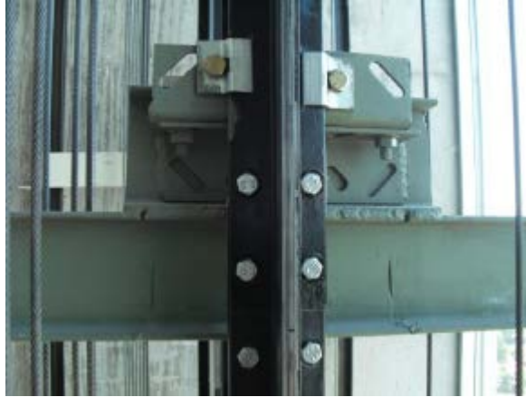
Figura N° 7: Riel guía de un ascensor, seminario CDT "Diseño y compra de ascensores".
