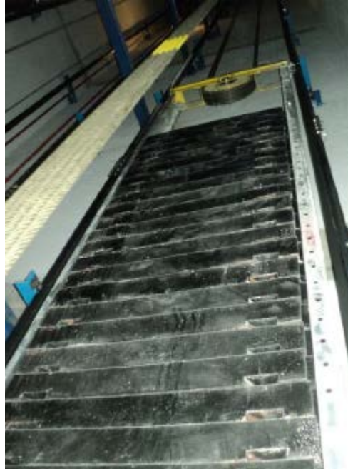
Figura N° 4: Contra peso de un ascensor, seminario CDT "Diseño y compra de ascensores".
