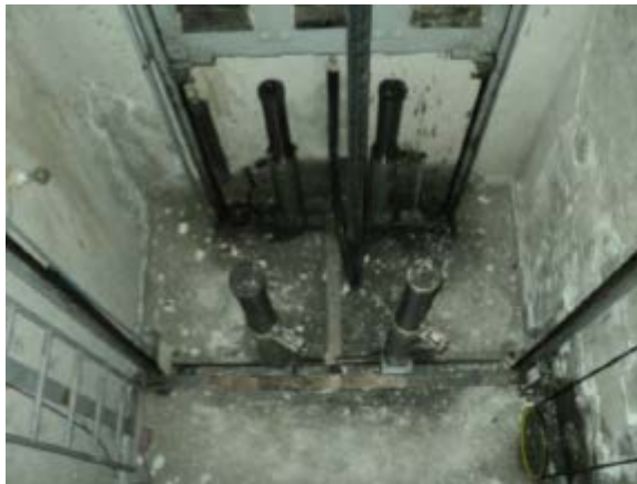
Figura N° 6: Interior pozo ascensores, seminario CDT "Diseño y compra de ascensores".
