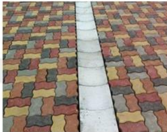
Confinamiento solera Tipo A
