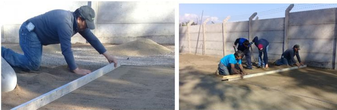
Confección de cama de arena con regla. Cuadrilla de trabajo con personal esparciendo la arena y otros compactando y alisando.
