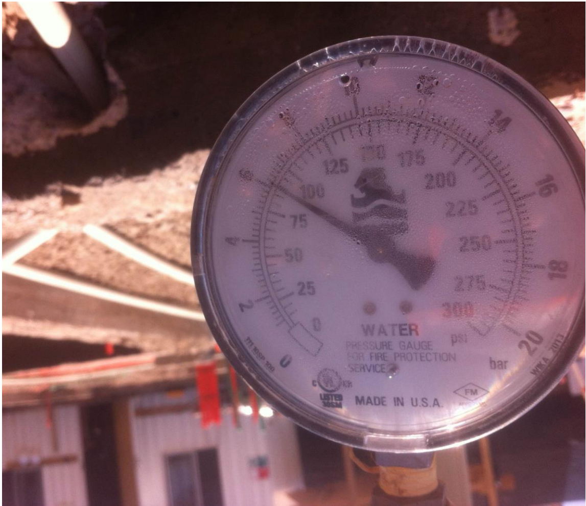
Figura 2-8 Prueba de presión casa 1
