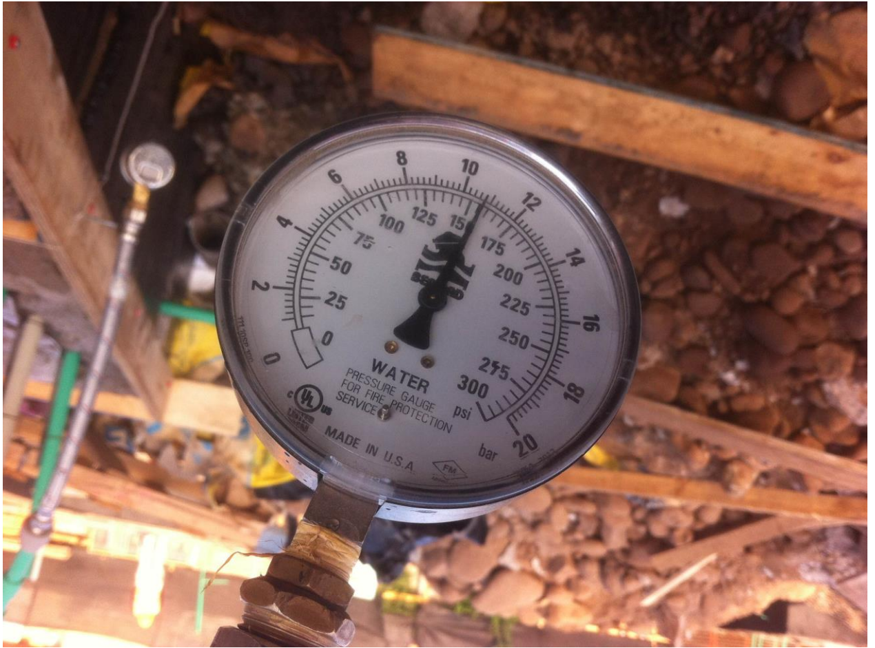
Figura 2-4 Prueba de presión casa 6
