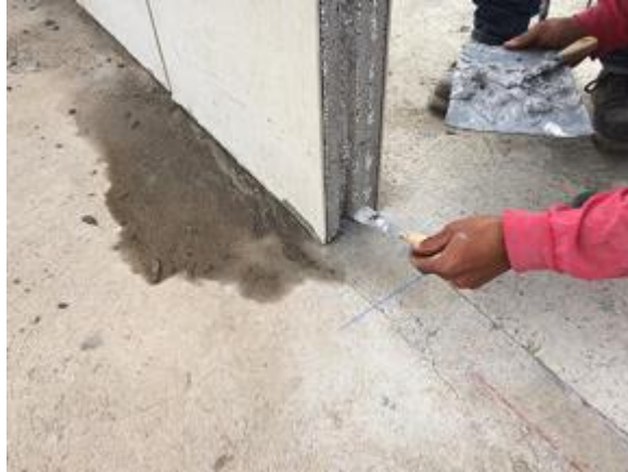
Figura 2-30 Aplicación de Adhesivo
