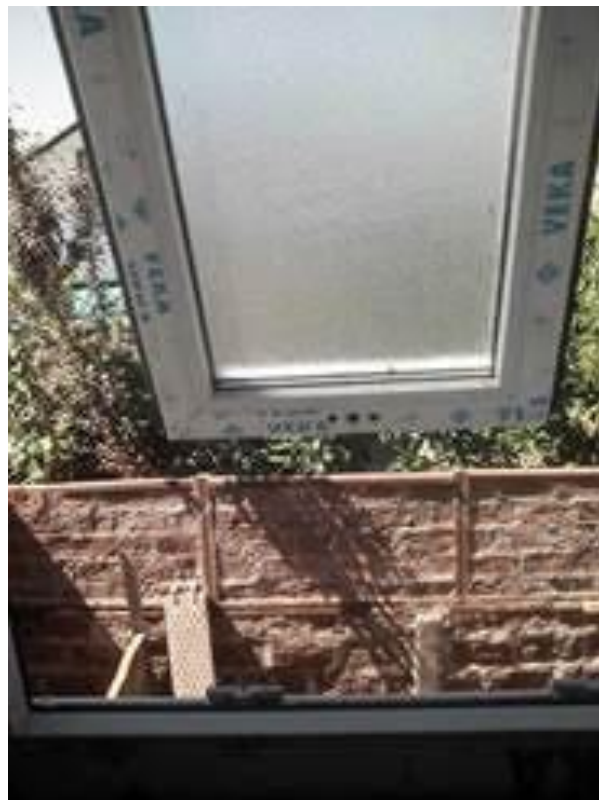
Figura 2-24 Detalle punto de cierre ventana baño Casa 10
