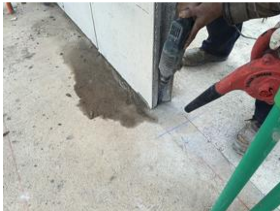
Figura 2-29 injerto de barra de acero
