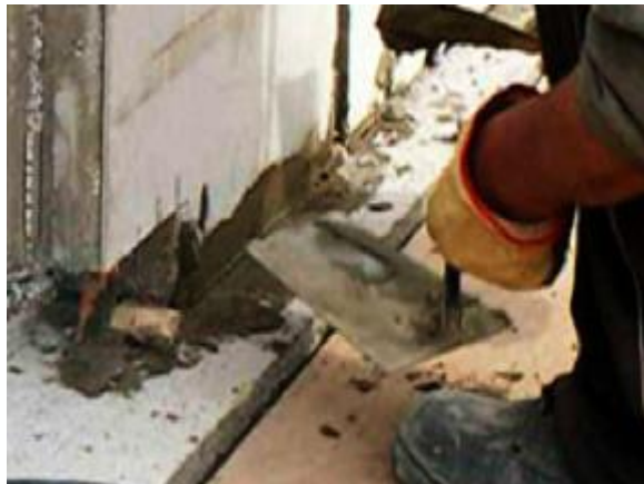
Figura 2-37 Fraguado de Panel
