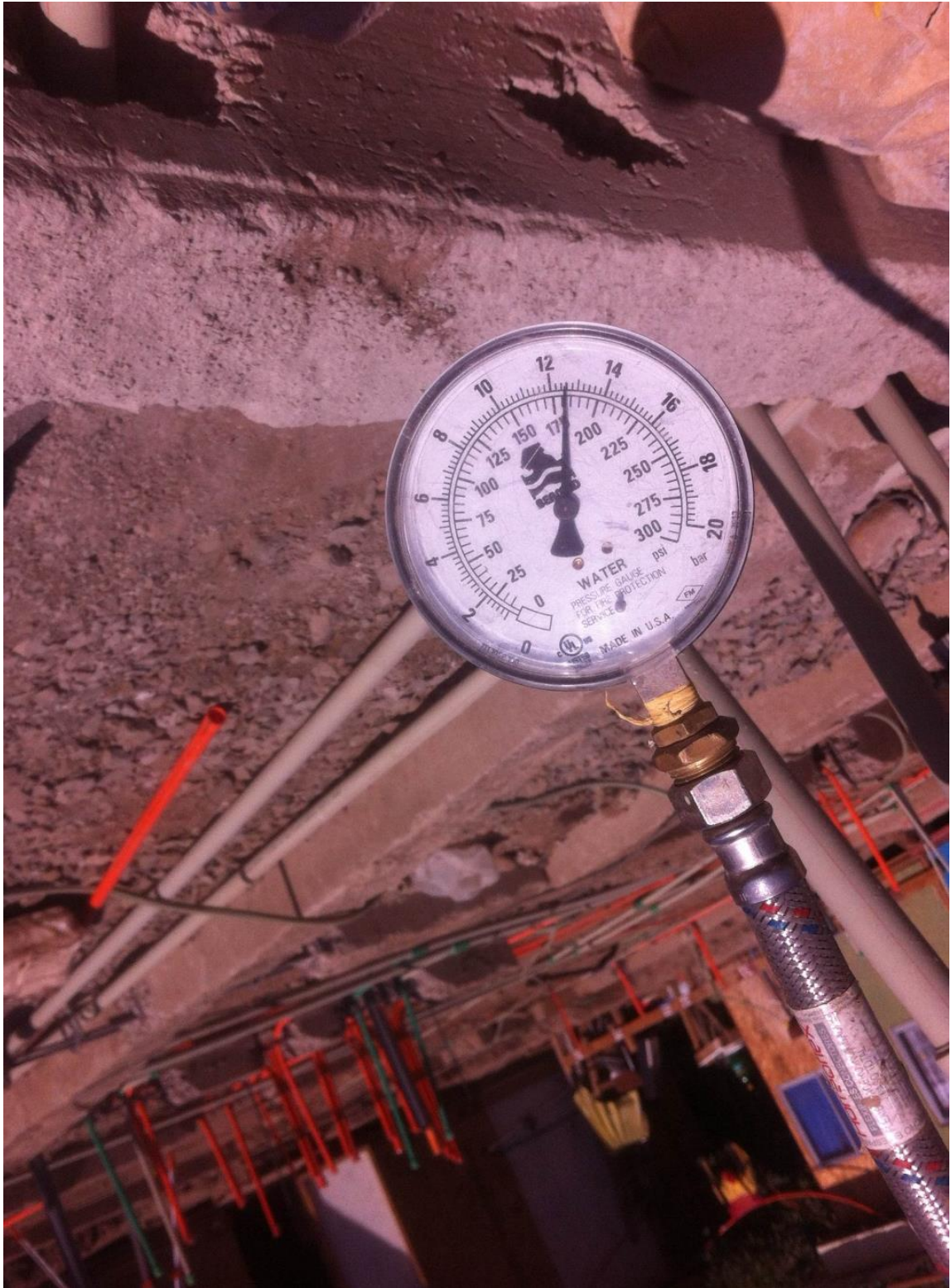
Figura 2-9 Prueba de presión casa 1
