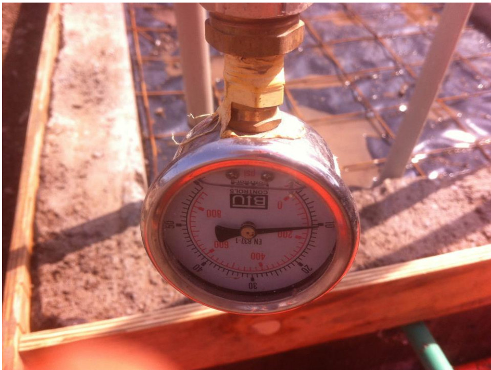
Figura 2-5 Prueba de presión casa 7
