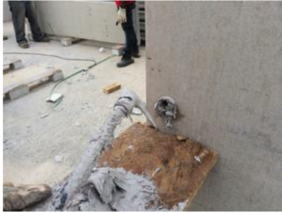
Figura 2-32 Aplicación Adhesivo Estructural en barras de acero
