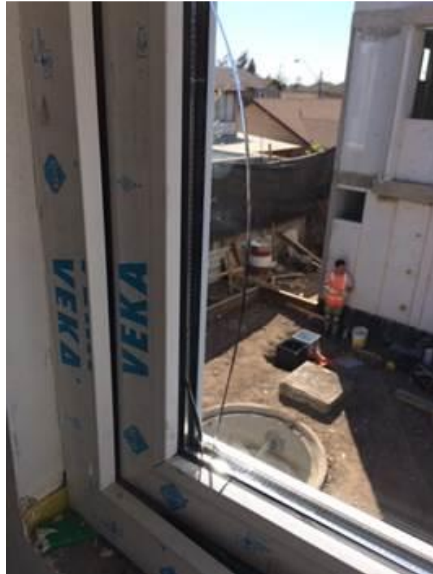
Figura 2-19 Detalle Vidrio Piso 2 Casa 7
