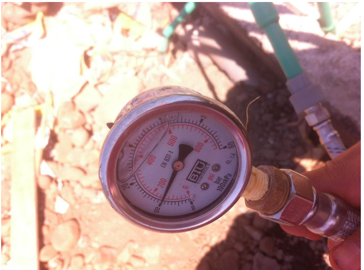
Figura 2-2 Prueba de presión casa 4
