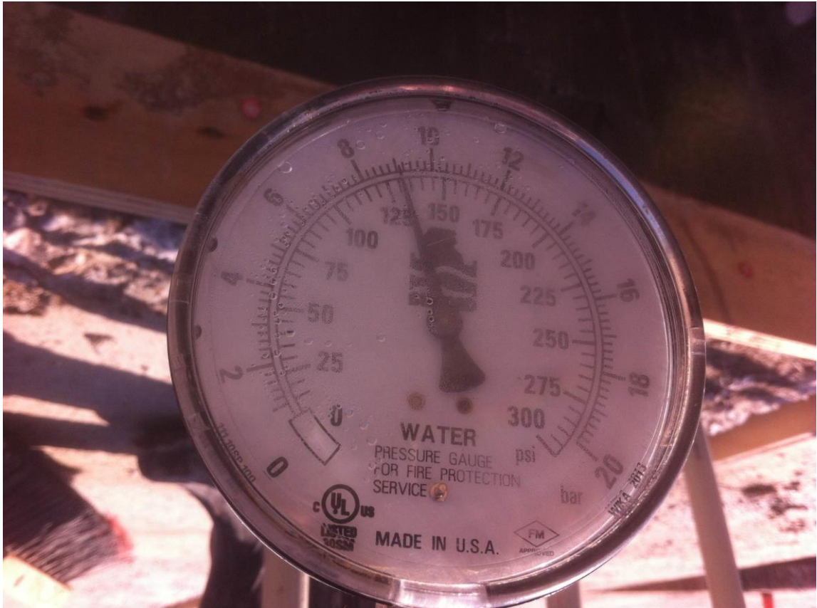
Figura 2-6 Prueba de presión casa 8
