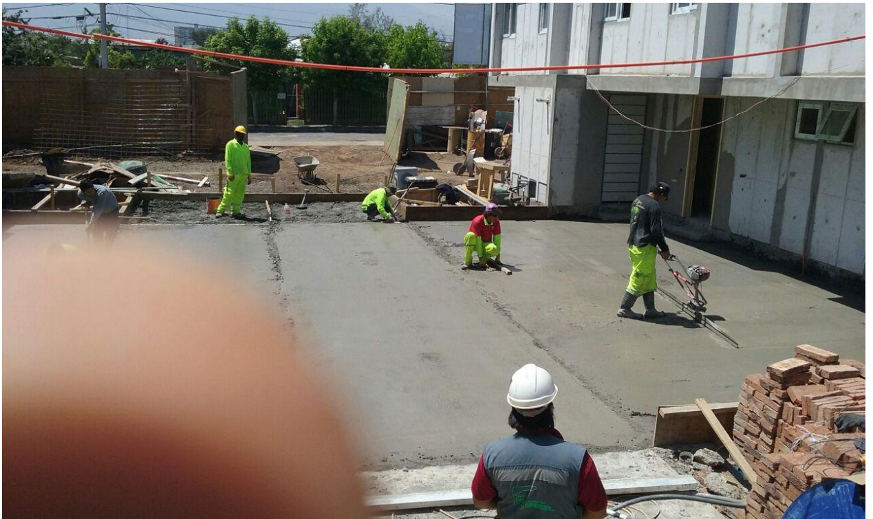
Figura 2-27 Nivelado Calle Condominio Tierra Cordillera
