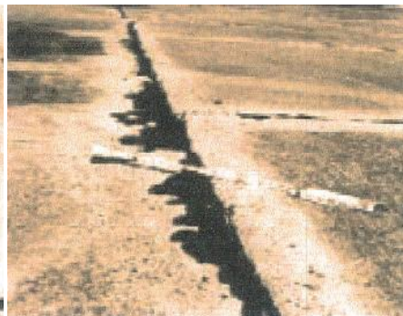
Figura 76: Escalonamiento de severidad media. [6]
