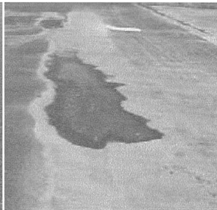
Figura 29: Depresión de severidad baja. [6] Figura 30: Depresiones de severidad media. [6] Figura 31: Depresiones de severidad alta. [6]
