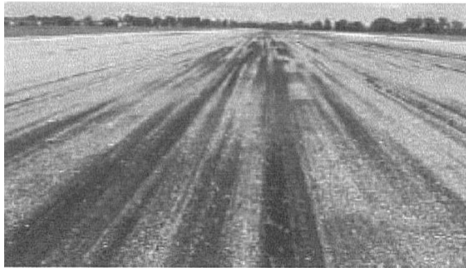
Figura 32: Erosión por Chorro de Turbina. [6]
