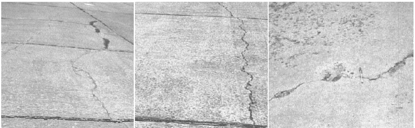
Figura 56: Grietas L&T de severidad baja. [6] Figura 57: Grietas L&T de severidad media. Figura 58: Grietas L&T de severidad alta. [6] [6]
