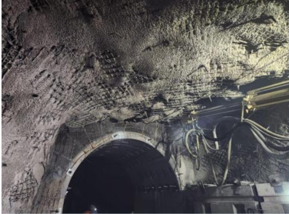
Figura 1-10. Relleno de hormigón proyectado.
