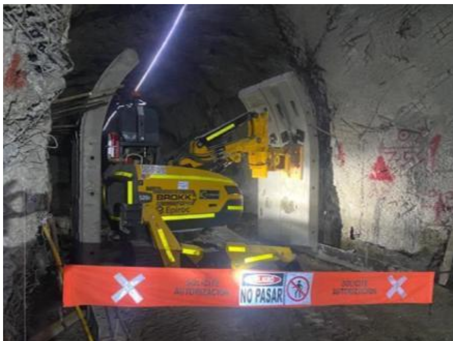
Figura 1-8. Instalación de marcos prefabricados mediante brokk.
