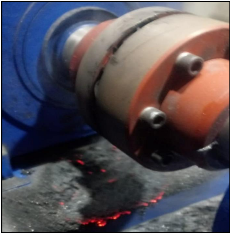
Figura 3-3. Rotura en acoplamiento.
