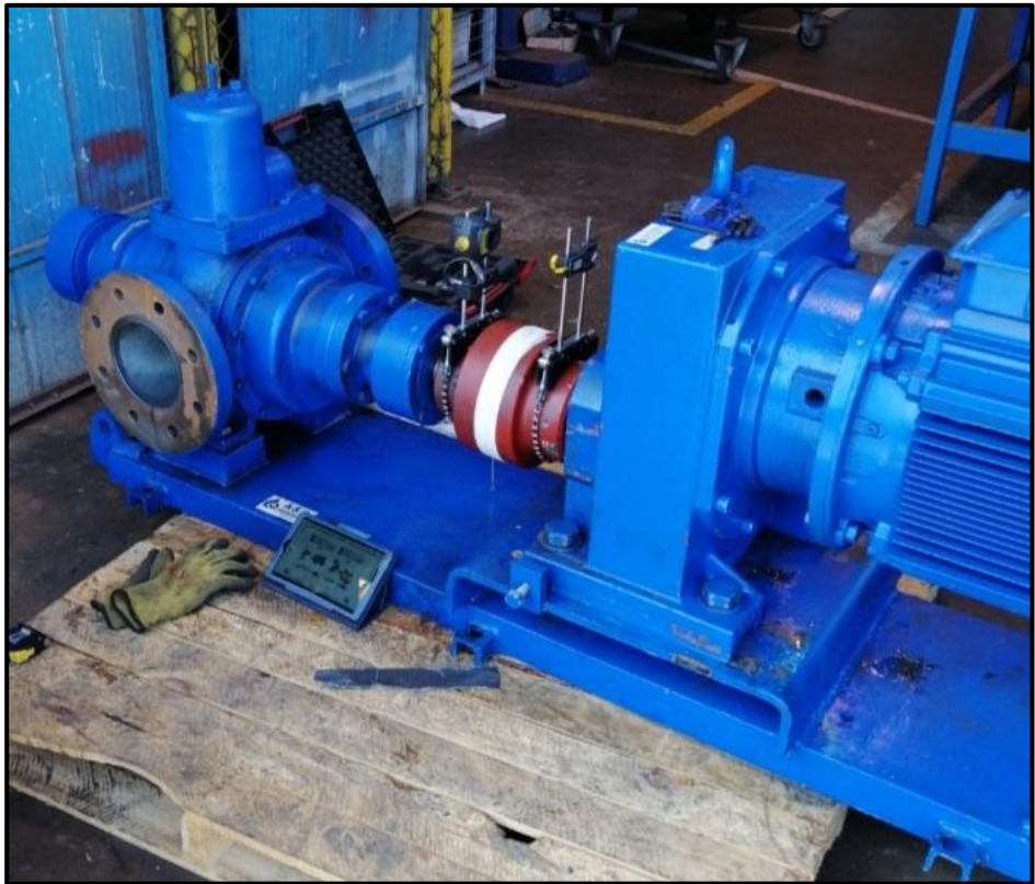
Figura 3-7. Trabajos de alineación de reductor – bomba.
