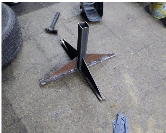
Figura 6.6: Proceso de soldado de conjunto inferior.
