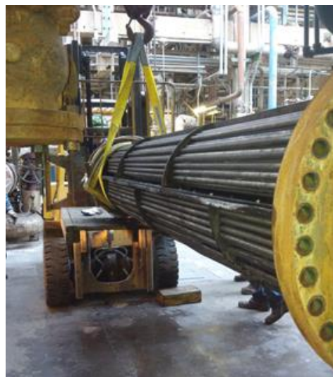
Figura XI.8: Maniobra típica de montaje para intercambiador tipo F. Fuente: Departamento de mantención, Enap Bío-Bío
