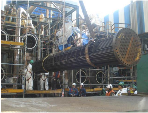
Figura IV.23: Desmontaje de haz de tubos de C-1201 durante paro de planta año 2015.
