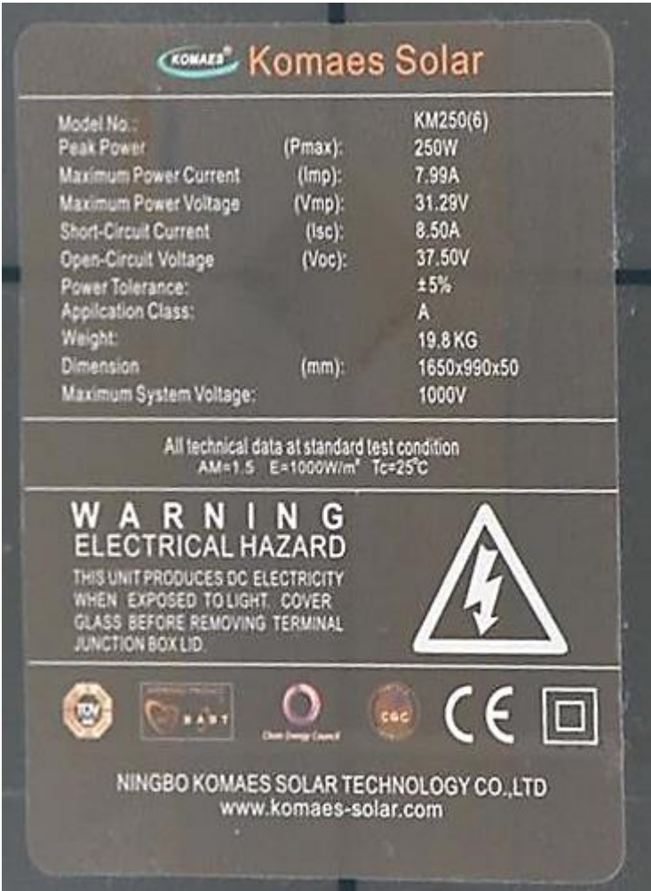
Figura 9.1 Datos de placa, panel fotovoltaico instalado
