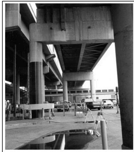
Figura 2 Puente Santa Mónica reparado con CFRP [1]
