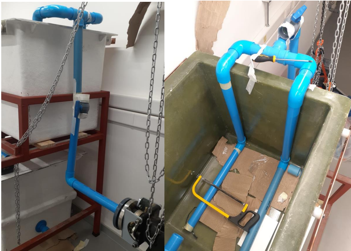
Figura 8.2 Instalación del piping
