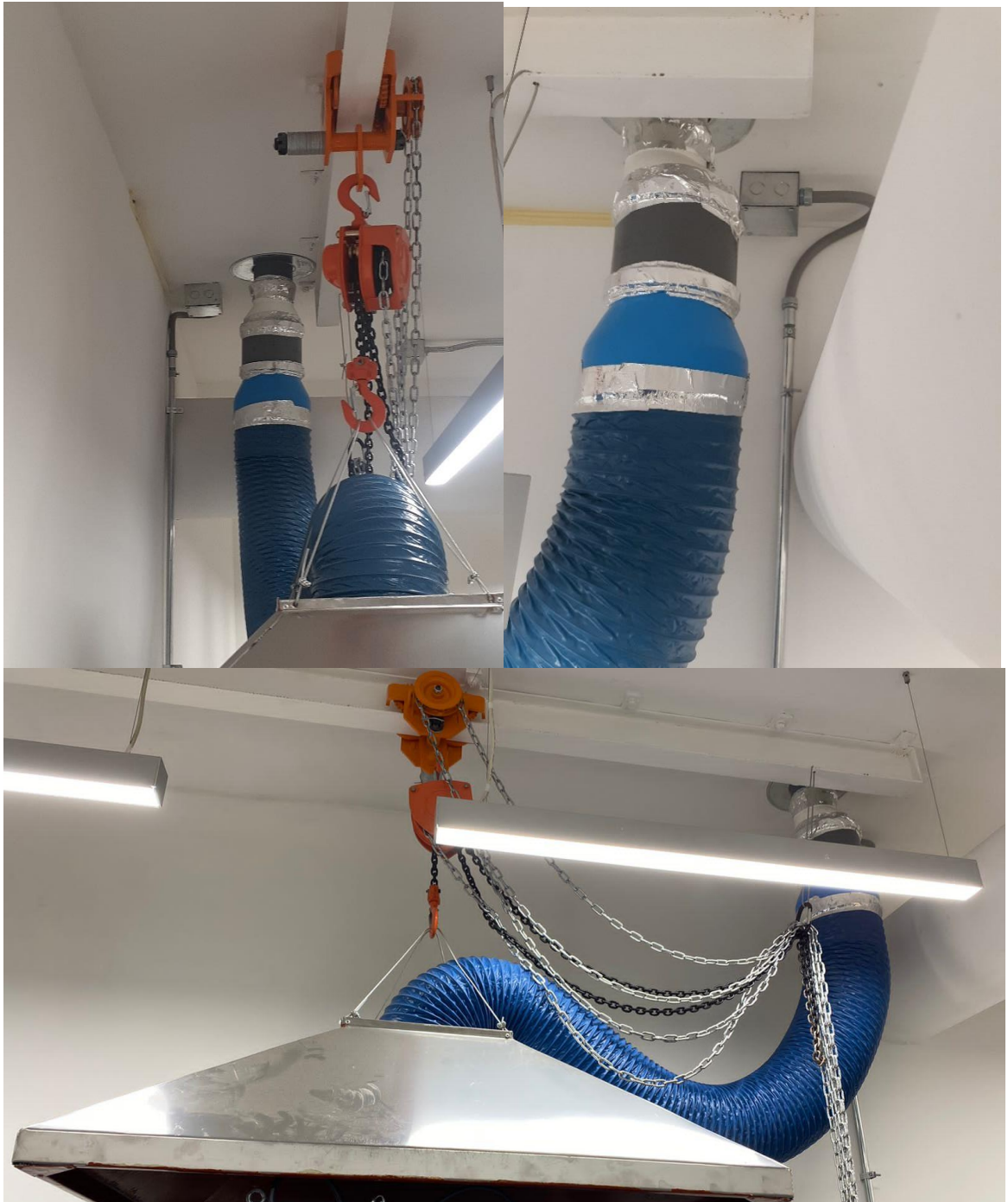
Figura 8.3 Instalación campana extractora
