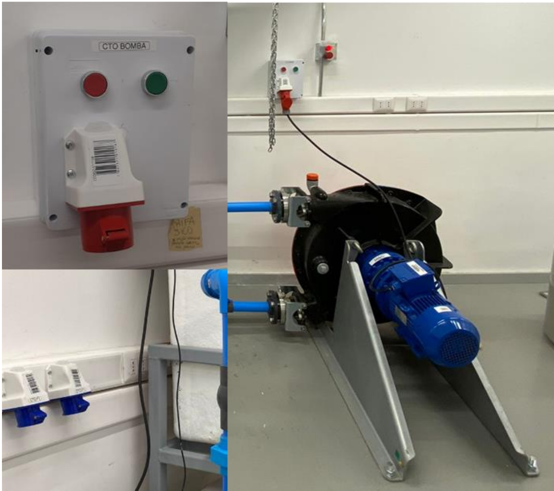
Figura 8.4 Conexiones eléctricas monofásicas y trifásicas
