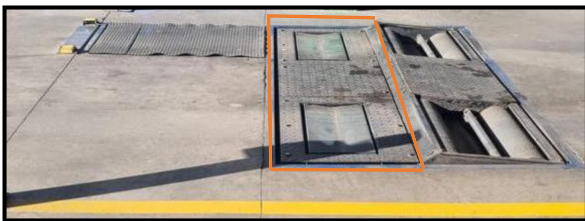
Figura 6. Conjunto de equipos de PRT destacado Prueba de Amortiguadores
