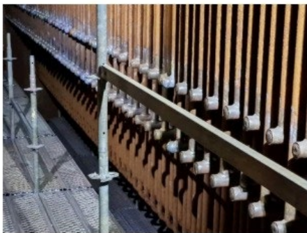
Figura 30: Economizador II – Lado Pared Trasera
