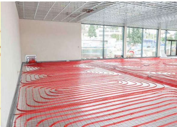
Figura 27 proceso de instalación
