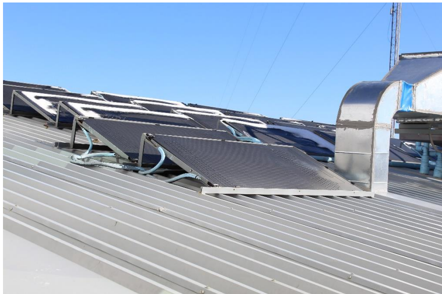
Figura 8 Paneles solares asociados al bloque termodinámico
