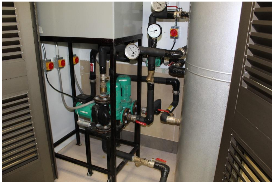
Figura 3 Sala térmica N°2 frente a vacunatorio
