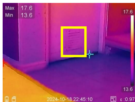
Ilustración 32. fotografía térmica de puerta baño principal
