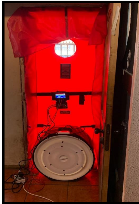
Ilustración 20. ensayo de Presurización
