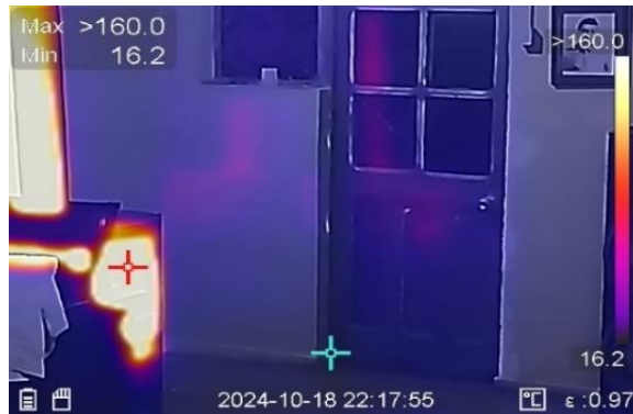
Ilustración 33. fotografía térmica de puerta de acceso ingreso a sector cocina
