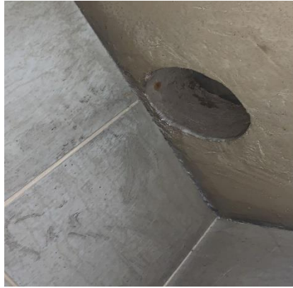
Ilustración 29. fotografías de perforación de la losa hacia el segundo piso
