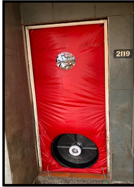
Ilustración 23. ensayo de despresurización
