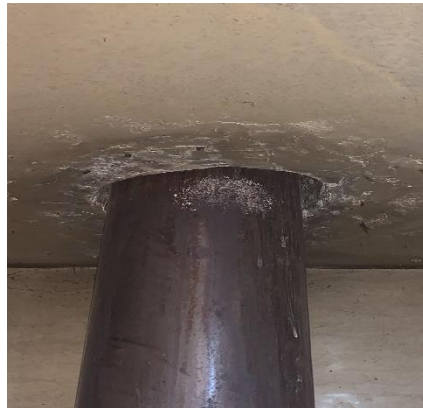
Ilustración 30. fotografías de perforación de la losa hacia el segundo piso
