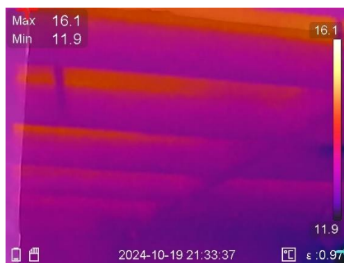
Ilustración 41. fotografía térmica de piso ventilado dormitorio n°4
