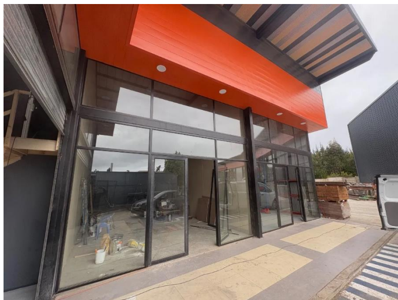
Figura 1.4: Vista exterior local comercial.
