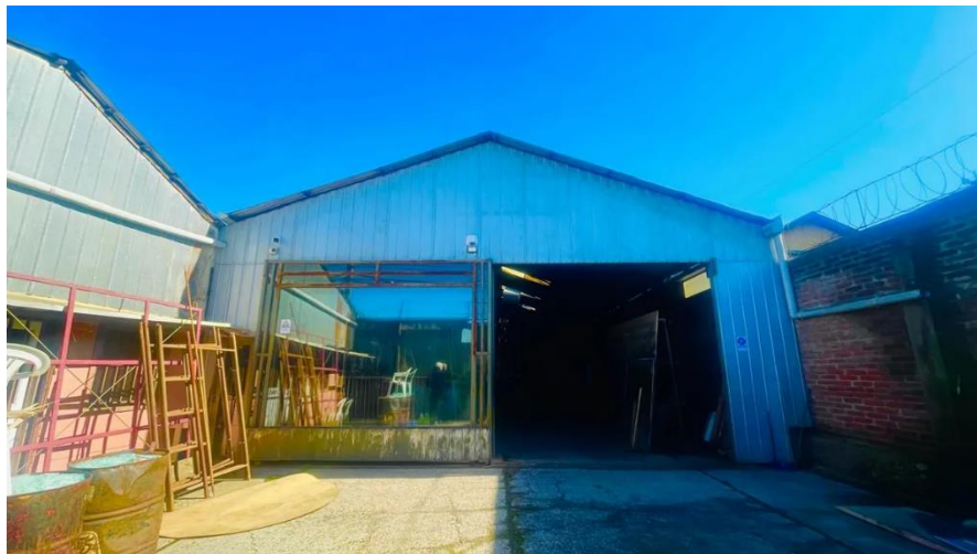
Figura 1.2: Vista exterior galpón.
