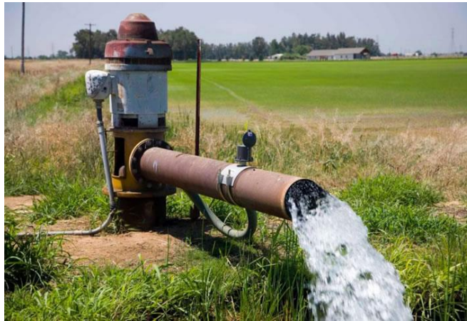
Imagen N°8: Extracción de Agua - Puntera
