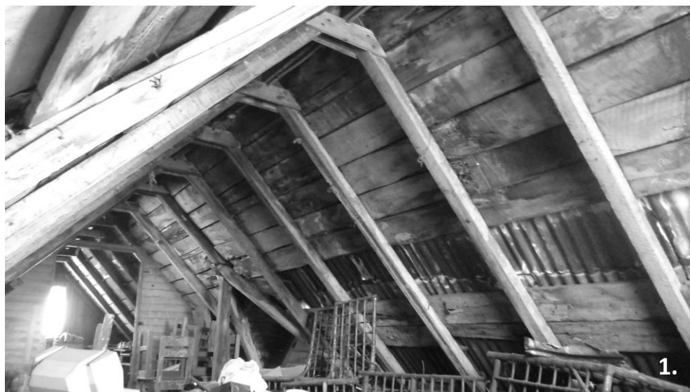
1. Fotografía de la armadura de techumbre: tijerales. Fuente: Colección fotográfica del autor, 2016.
