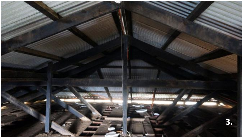
3. Fotografía de la estructura de techumbre. Fuente: Colección fotográfica del autor, 2016.
