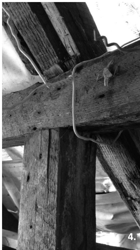
3. Fotografía detalle unión tirante y par. Fuente: Colección fotográfica del autor, 2016.
