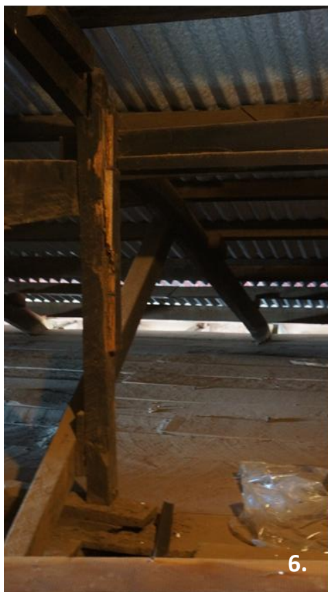
5. Fotografía de Detalle unión embarbillado entre pie derecho y diagonal. Fuente: Colección fotográfica del autor, 2016.
