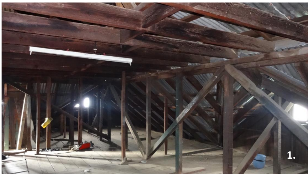
1. Fotografía pórticos de la armadura de techumbre. Fuente: Colección fotográfica del autor, 2016.
