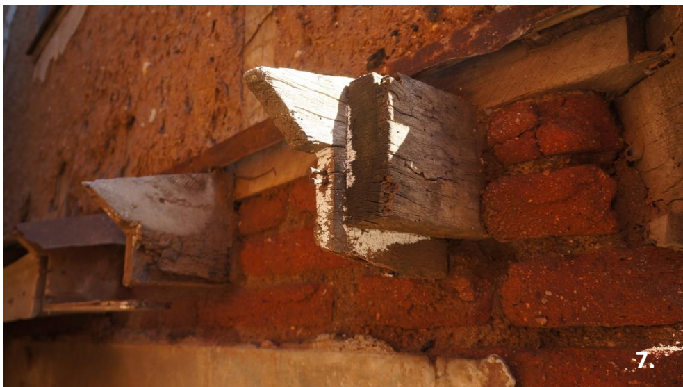
◀ 7. Fotografía de detalle vigas de madera y albañilería de ladrillos. Fuente: Colección fotográfica del autor, 2016.
