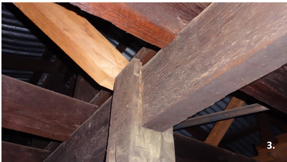
3. Fotografía detalle unión de quijera entre pie derecho y solera superior. Fuente: Colección fotográfica del autor, 2016.
