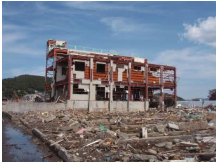
Figura 3-2. Edificio de marcos de acero analizado en Japón, sin daño estructural importante [Futamura. 2017].
