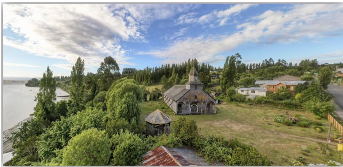
Figura 19. Vista general de la Iglesia Natividad de María de Ichuac, ubicada en la comuna de Puqueldón, Isla Lemuy, Archipiélago de Chiloé. Fuente: Ruta de las Iglesias de Chiloé.
