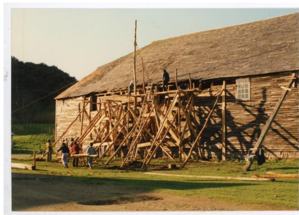
Figura 13. Andamios para la restauración de una iglesia de la Escuela Chilota, construidos por alumnos de la escuela de carpinteros de la comunidad de Quinchao, 1995. Fuente: Fundación Iglesias Patrimoniales de Chiloé.
