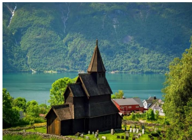
Figura 7. Iglesia de madera de Urnes, Ornes, Noruega, ejemplo de conservación de arquitectura religiosa en madera mediante mantención continua. Fuente Madera21. (2020). Iglesia de Urnes, Noruega [Fotografía de Robert Harding]. https://www.madera21.cl
