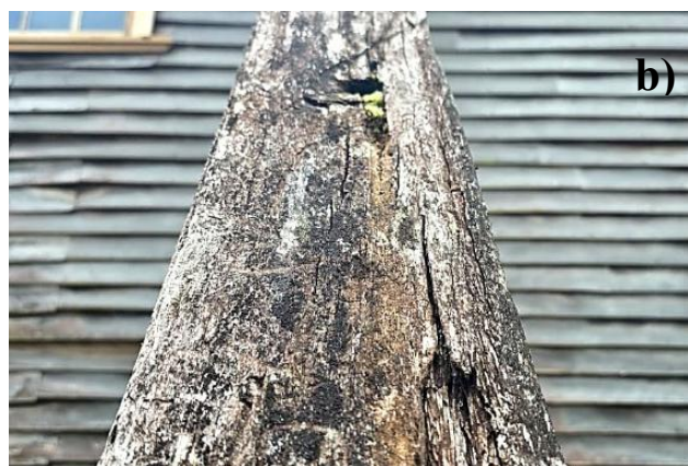
Figura 6. Iglesia de Ichuac antes del reemplazo de los puntales, noviembre de 2025. (a) Fachada este con los puntales de refuerzo instalados hacia 2005; (b) detalle de un puntal de coigüe con pudrición avanzada tras cerca de dos décadas de exposición. Fotografías de la autora, 11 de noviembre de 2025.
