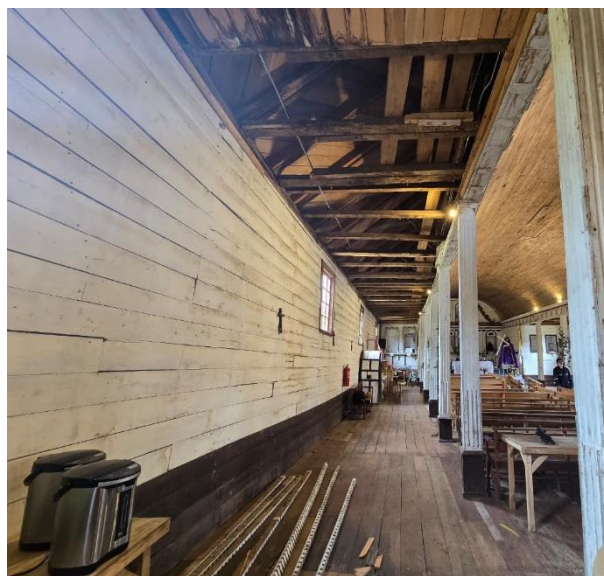
Figura 36. Interior nave oeste. Madera al natural sin recubrimiento. Fotografía de la autora, noviembre 2025.
