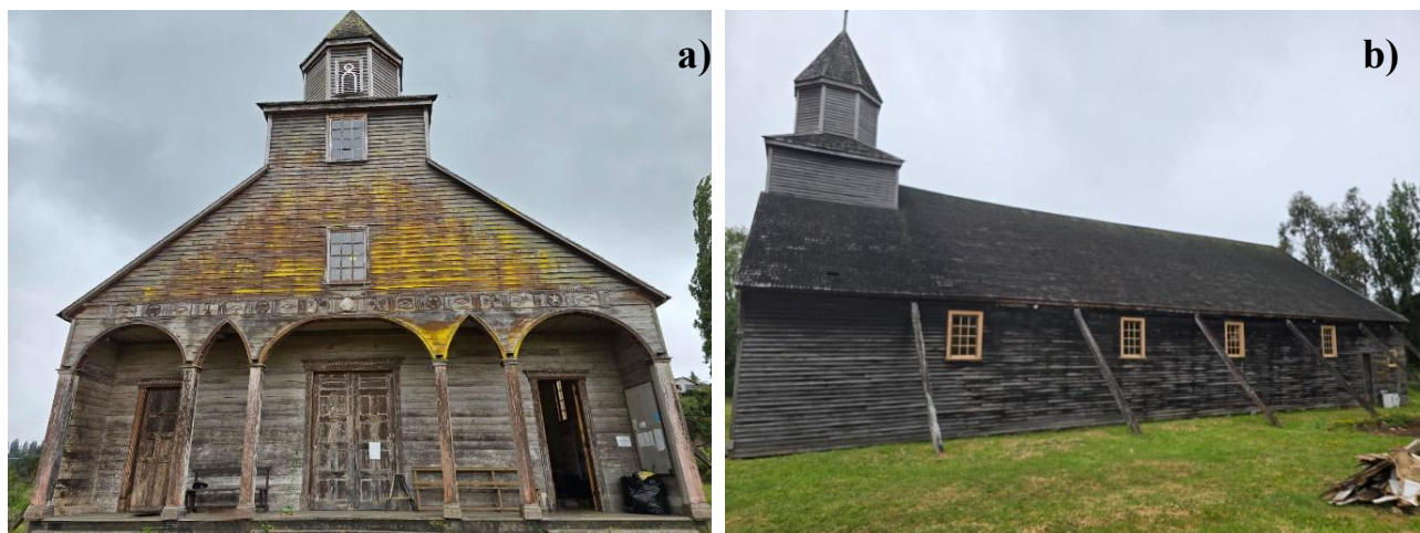
Figura 21. Estado general del inmueble. (a) fachada frontal completa, con el pórtico de tres arcos ojivales rebajados y la torre; (b) elevación lateral larga, con puntales inclinados. Fotografías de la autora.
