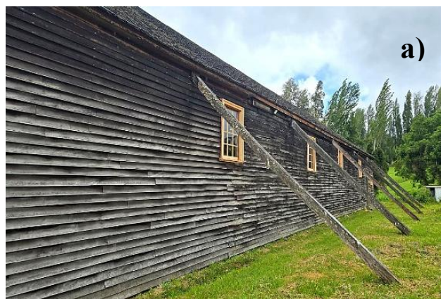
Figura 6. Iglesia de Ichuac antes del reemplazo de los puntales, noviembre de 2025. (a) Fachada este con los puntales de refuerzo instalados hacia 2005; (b) detalle de un puntal de coigüe con pudrición avanzada tras cerca de dos décadas de exposición. Fotografías de la autora, 11 de noviembre de 2025.
