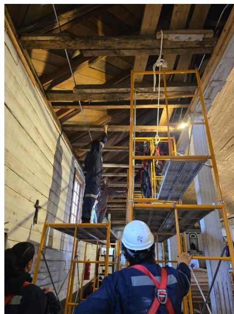
Figura 28. Faena de reposición de piezas deterioradas del cielo en el interior de la Iglesia Natividad de María de Ichuac. Fotografía de la autora, 11 de noviembre de 2025.
