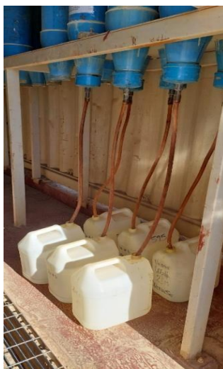
Figura 26. Piso 1. Sistema de drenaje.
