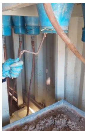
Figura 58. Descarga de columna con ayuda de gancho estridente.
