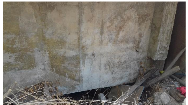
Figura 8-166 junta entre viga y estribo
