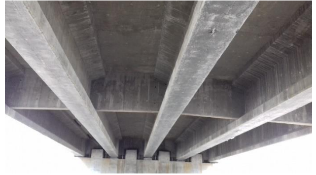
Figura 8-102 subestructura con elementos antisísmicos
