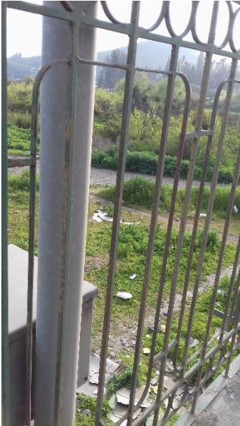
Figura 8-2 Baranda de acero
