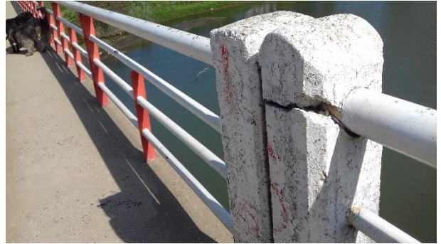
Figura 8-8 Baranda de acero y hormigón
