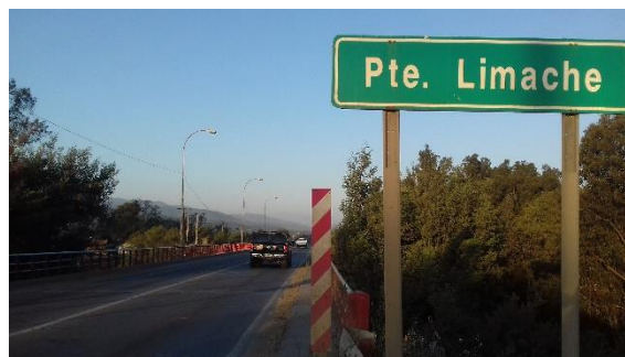
Figura 8-59 vista general puente Limache
