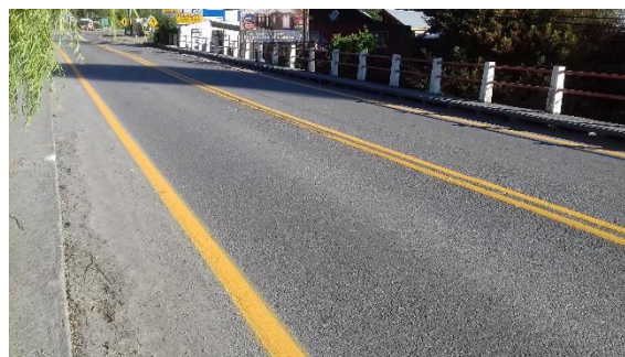
Figura 8-116 vista general puente Rio Blanco
