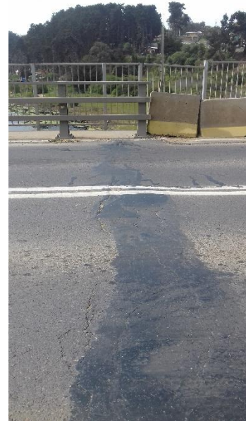
Figura 8-38 Deformación en la capa de rodado
