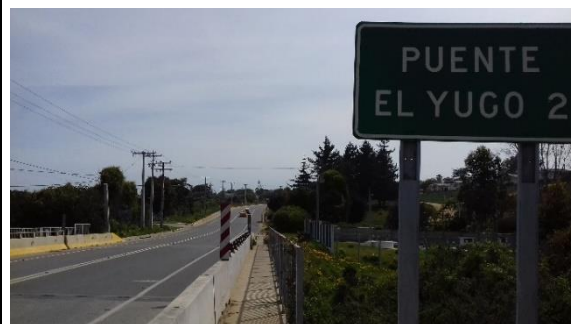
Figura 8-27 Vista general puente El yugo 2
