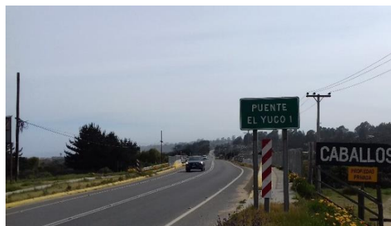
Figura 8-23 Vista general puente El Yugo 1
