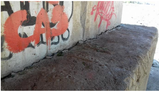
Figura 8-132 Sección rota en estribo
