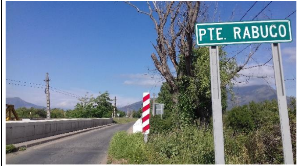
Figura 8-155 Vista general puente Rabuco
