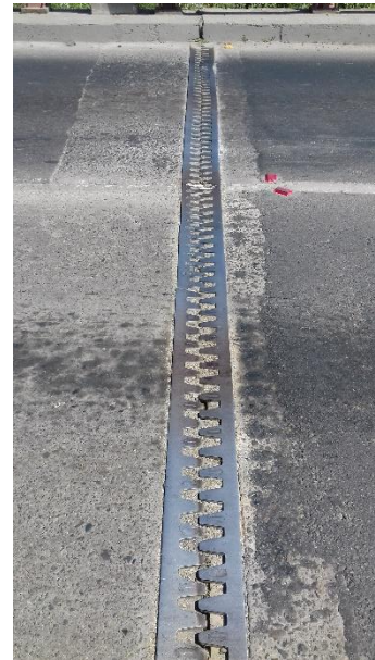
Figura 8-17 Junta de expansión dentada
