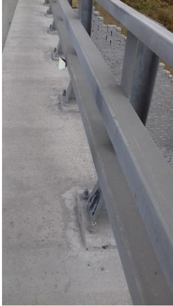
Figura 8-160 baranda de acero en buen estado
