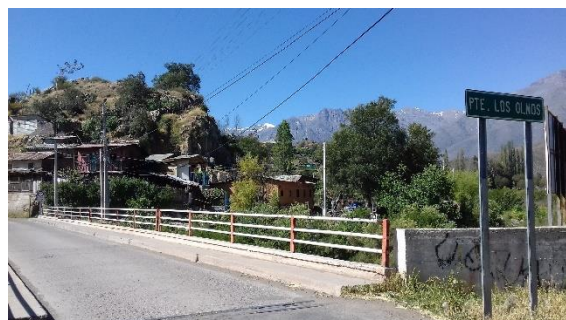
Figura 8-79 vista general puente Los Olmos
