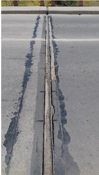
Figura 8-89 deformación en la junta de expansión
