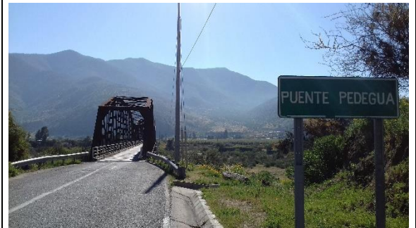
Figura 8-84 vista general puente Pedegua
