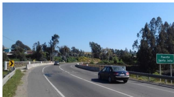
Figura 8-67 vista general puente Santa Julia
