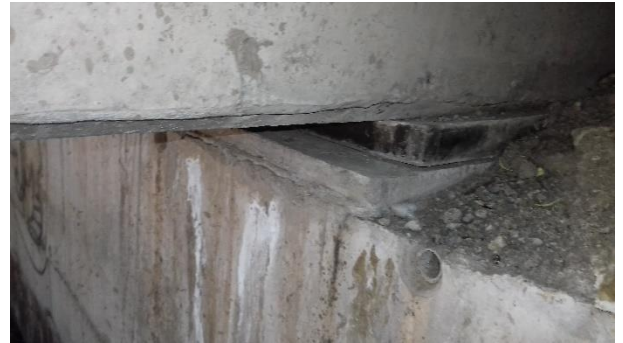
Figura 8-142 apoyos elastoméricos
