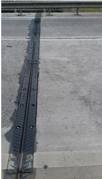
Figura 8-105 junta de expansión en buen estado
