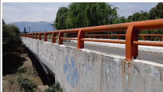
Figura 8-139 Vista general puente Mina Caracoles
