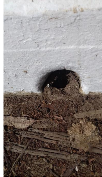
Figura 8-13 Taponamiento del drenaje
