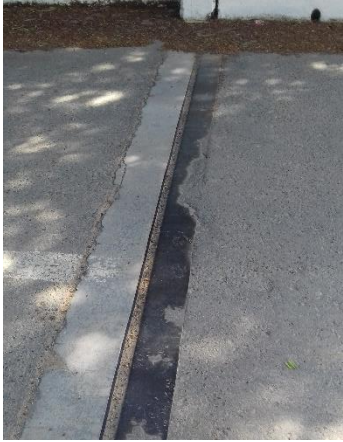
Figura 8-11 Junta de expansión rota
