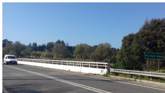
Figura 8-71 vista general puente Valle Alegre
