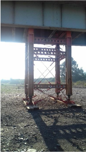
Figura 8-97 estructura de soporte del vano del medio
