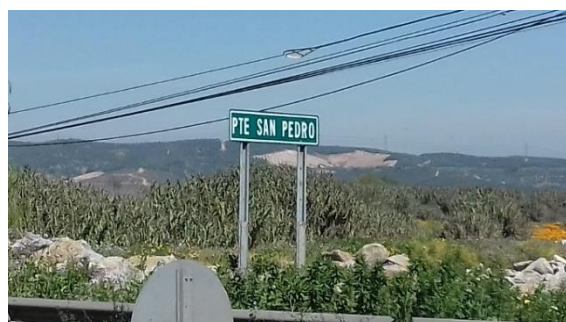
Figura 8-14 Vista general puente San Pedro
