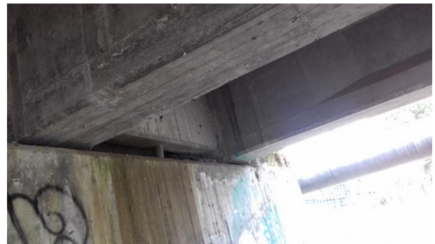
Figura 8-42 barras de acero y llave de corte
