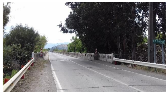
Figura 8-167 vista general puente Chagres
