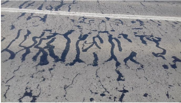
Figura 8-32 Superficie de rodado con parches
