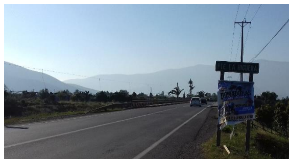
Figura 8-92 vista general puente La higuera
