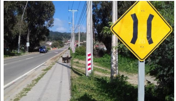
Figura 8-6 Vista general puente Lo manzano
