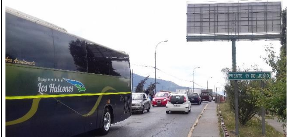
Figura 8-151 Vista general puente 19 de Junio
