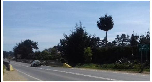
Figura 8-31 Vista general puente Seminario
