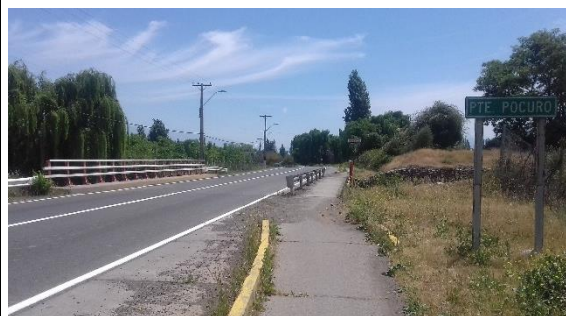
Figura 8-143 Vista general puente Pocuro
