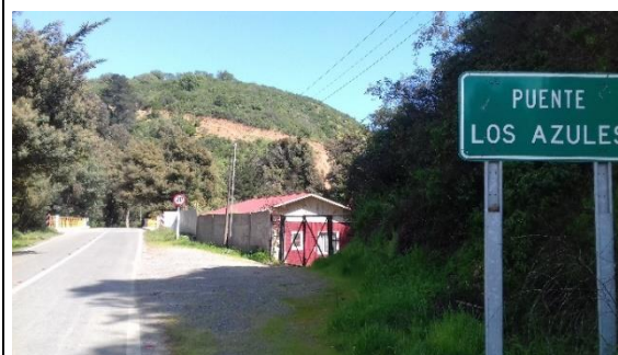
Figura 8-10 Vista general puente Los azules
