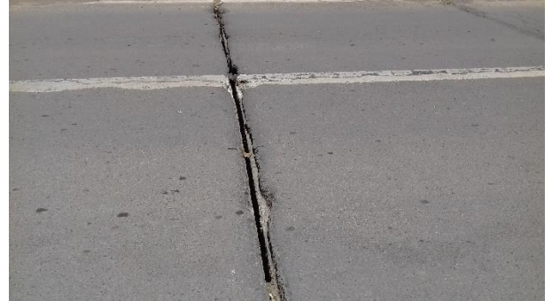
Figura 8-141 junta de expansión abierta
