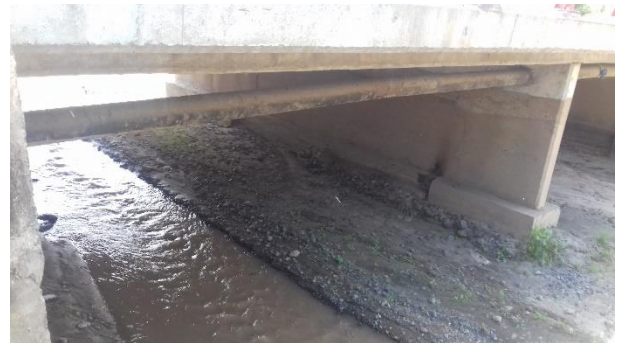
Figura 8-146 columna ancha y apoyo fijo
