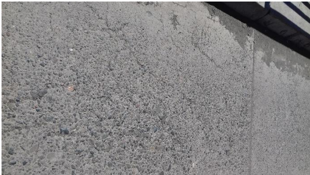
Figura 8-81 pavimento agrietado
