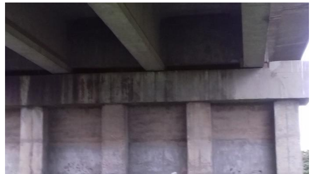
Figura 8-50 Subestructura y apoyos antisísmicos
