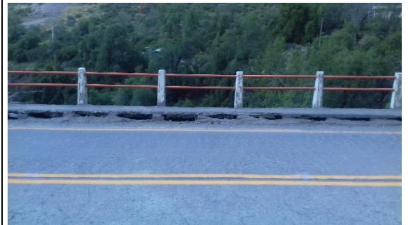
Figura 8-120 vista general puente Ventana
