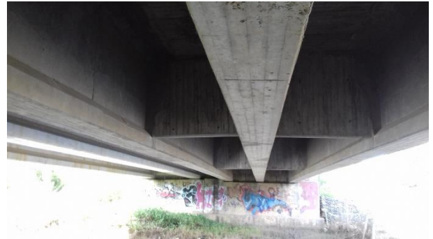
Figura 8-25 Viga principal en buen estado
