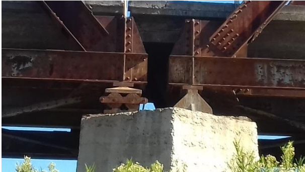
Figura 8-85 apoyo deslizante
