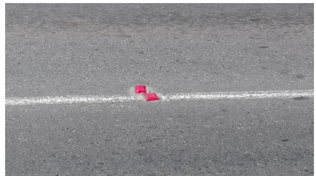
Figura 8-18 Luces rojas mal puestas
