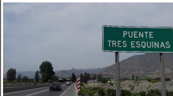
Figura 8-135 Vista general puente Tres Esquinas
