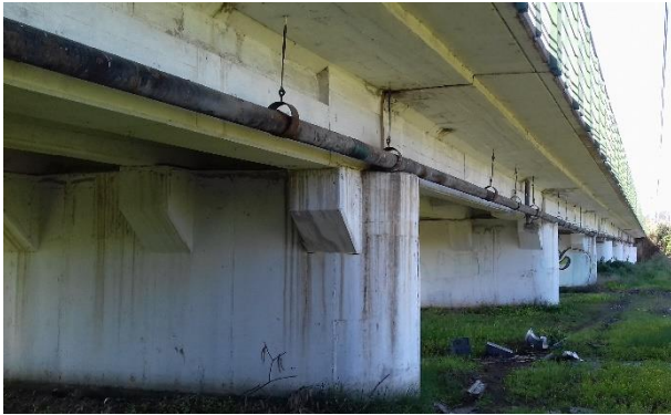
Figura 8-64 apoyos fijos sin resistencia sísmica
