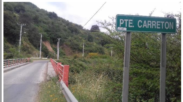
Figura 8-147 Vista general puente Carretón
