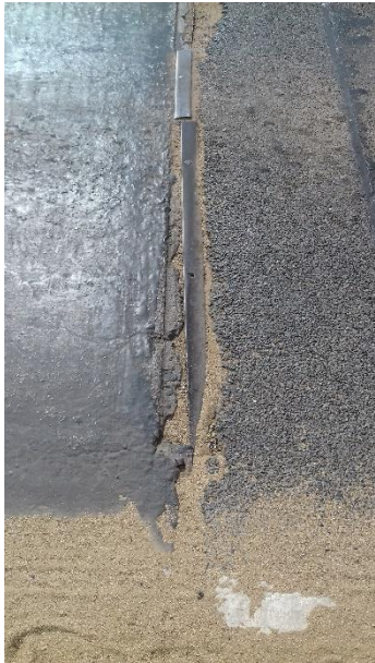
Figura 8-20 Junta de expansión rota
