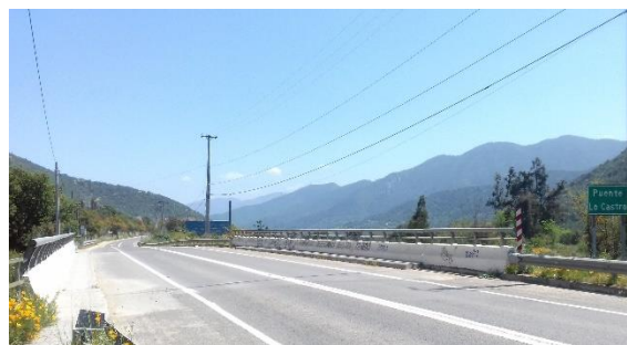
Figura 8-108 vista general puente Lo Castro
