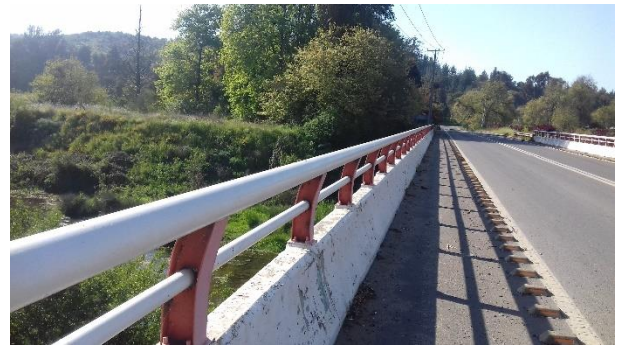
Figura 8-74 baranda de hormigón y acero
