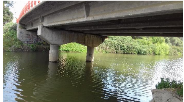
Figura 8-41 vista general de la subestructura
