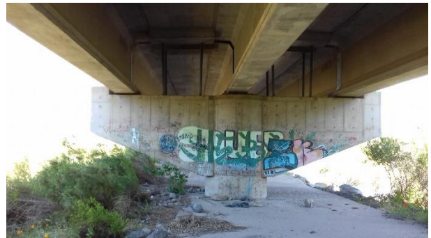
Figura 8-91 pilar de forma asimétrica
