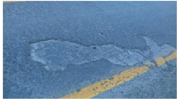
Figura 8-122 baches con acero expuesto
