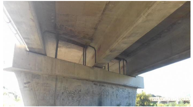
Figura 8-95 Barras de acero y llave de corte
