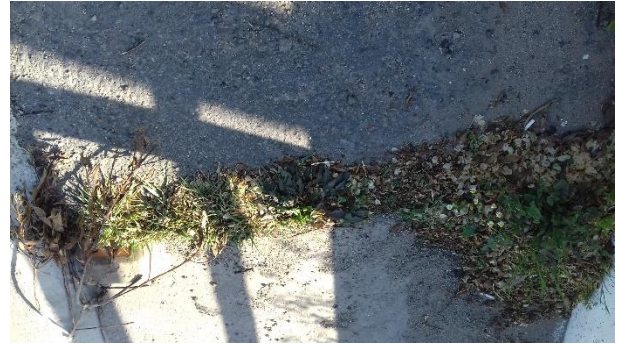
Figura 8-73 junta obstruida
