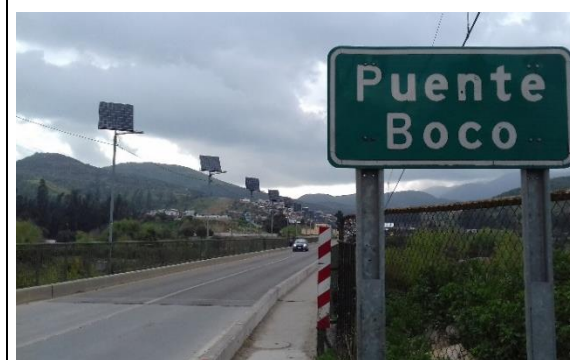
Figura 8-1 Vista general puente Boco
