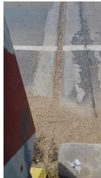
Figura 8-30 Junta obstruida
