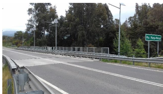
Figura 8-104 vista general puente Marga-Marga
