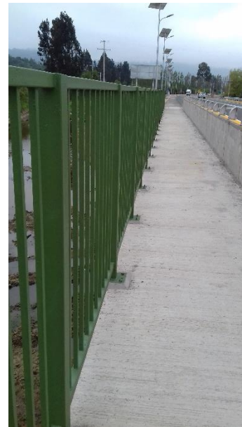
Figura 8-103 baranda de acero en muy buen estado
