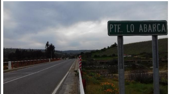
Figura 8-43 vista general puente Lo Abarca
