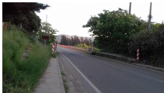
Figura 8-55 vista general puente Colmo
