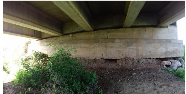
Figura 8-70 subestructura en curva con pendiente
