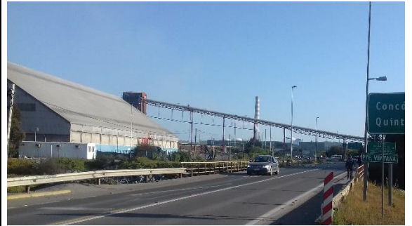
Figura 8-75 vista general puente Ventana
