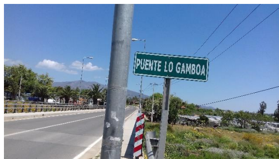
Figura 8-112 vista general puente Lo Gamboa
