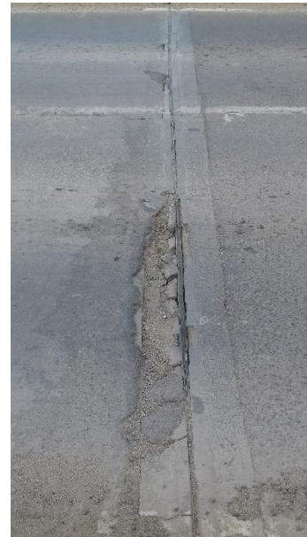
Figura 8-4 Junta de expansión rota
