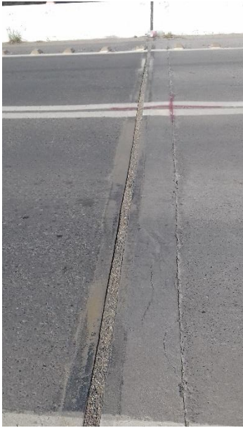
Figura 8-72 deformación del asfalto
