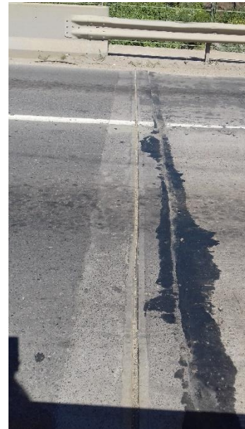
Figura 8-66 junta de expansión
