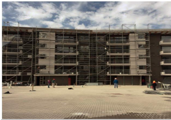
Imagen 1.6.4 Construcción edificio Vista al Estero
