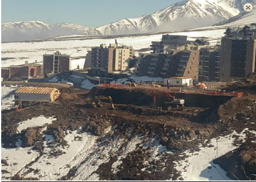
Imagen 1.6.1 Construcción edificio Vista al Estero
