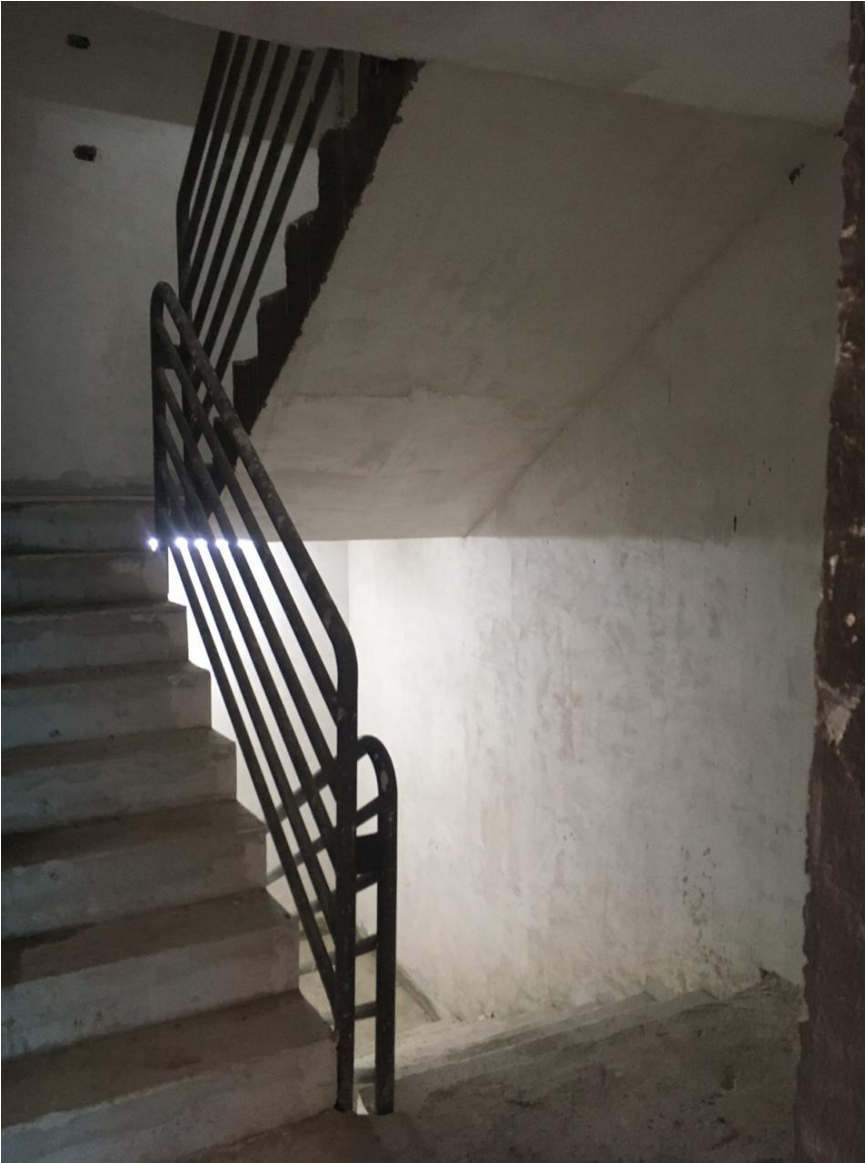
Imagen 3.6 Escaleras Emergencia interior edificio "Vista al Estero"
