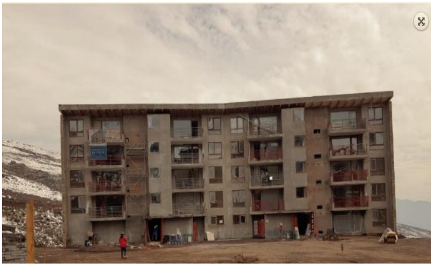
Imagen 1.6.2 Construcción edificio Vista al Estero
