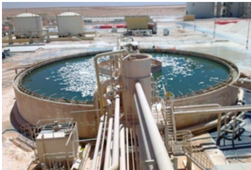
(a) Espesamiento: Proceso de concentración de mineral basado en la decantación
