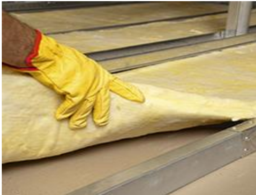
Figura 3-2 Instalación de lana Mineral sobre cubierta en entretecho Fuente: Google Imágenes
