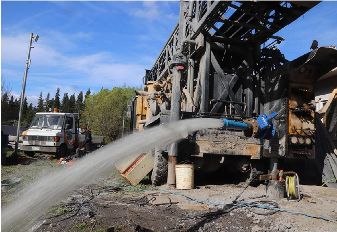
Figura 1-15 Pruebas de bombeo del pozo de extracción en Liceo Bicentenario Altos del Mackay Fuente: CEGA
