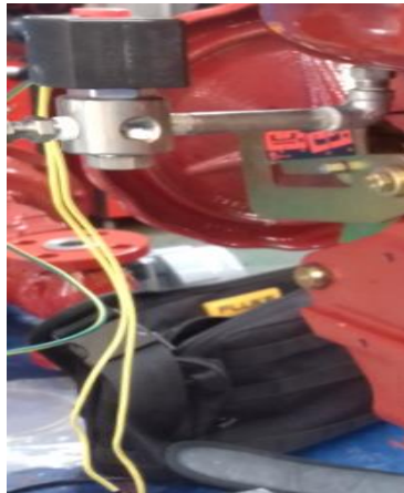
Ilustración 8-7: Solenoide en la entrada de la válvula.
