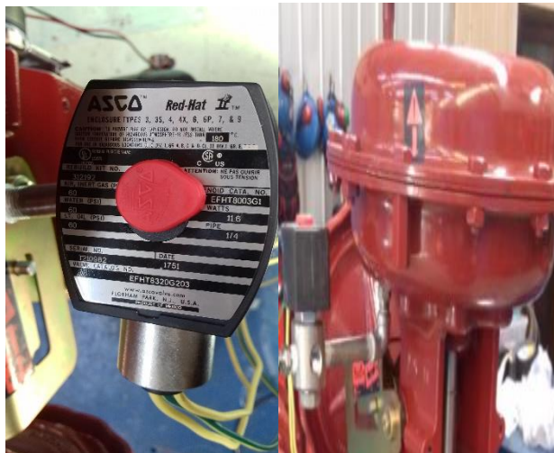
Ilustración 8-3: Válvula solenoide.
