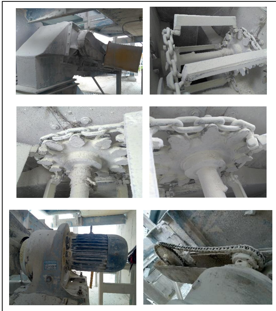
Figura 3-30. Estado actual del sistema de arrastre del transportador
