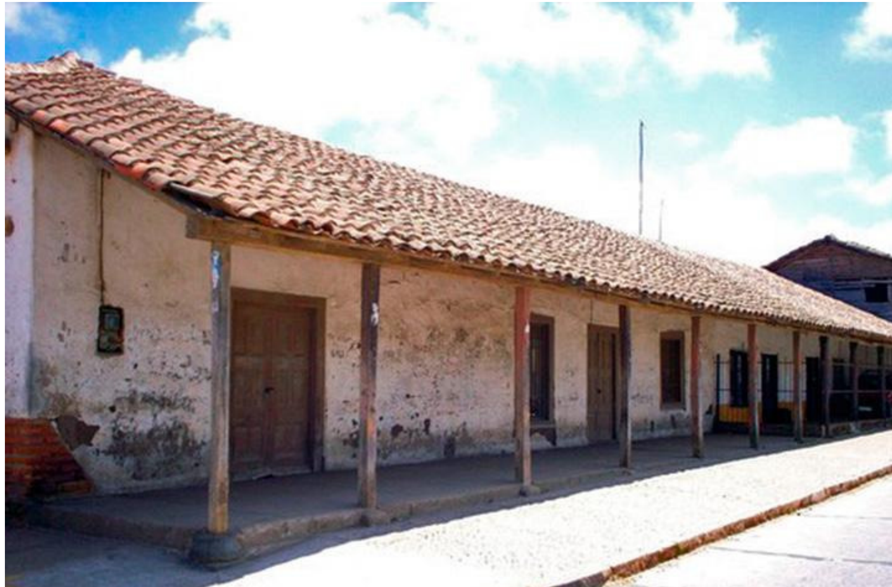
Figura: Vivienda tradicional de adobe en la zona central de Chile. Fuente: www.cabalgataschile.cl
