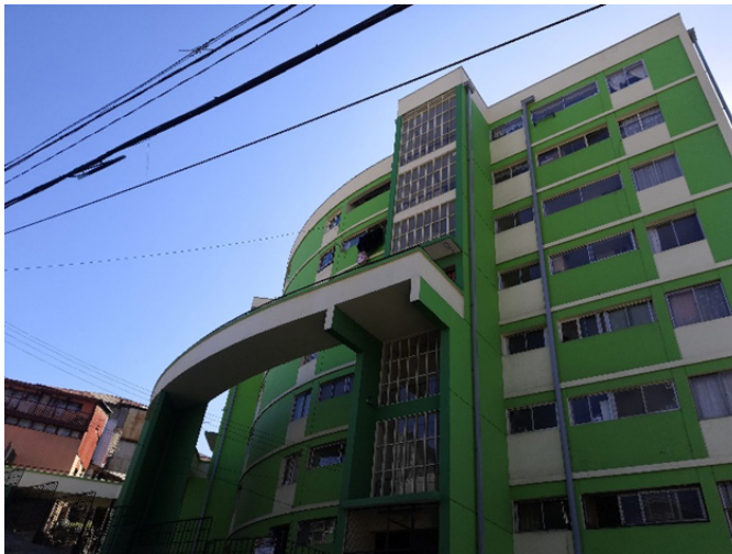
Ilustración 106: Fotografía bloque A “Edificio Curvo” “de la 2da etapa, “Quebrada Márquez Ampliación”, con un cuerpo que se alza como un sólido. Fuente propia
