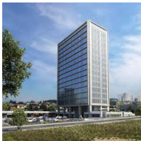
Figura 26: Edificio Open Montemar
