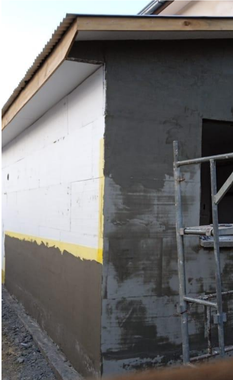
Figura 20. Estuco elastomérico en muro izquierdo aplicado desde abajo hacia arriba.
