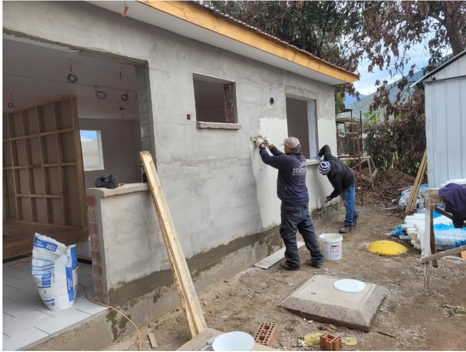
Figura 23. Imagen proceso EIFS por la empresa ICUFER Construcciones Ltda.
