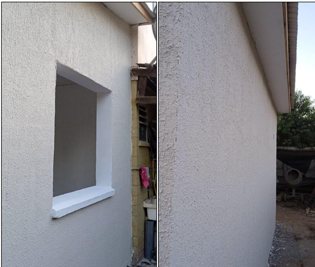
Figura 21. Acabado final de muros con sistema EIFS proyectos empresa ICUFER Construcciones Ltda.
