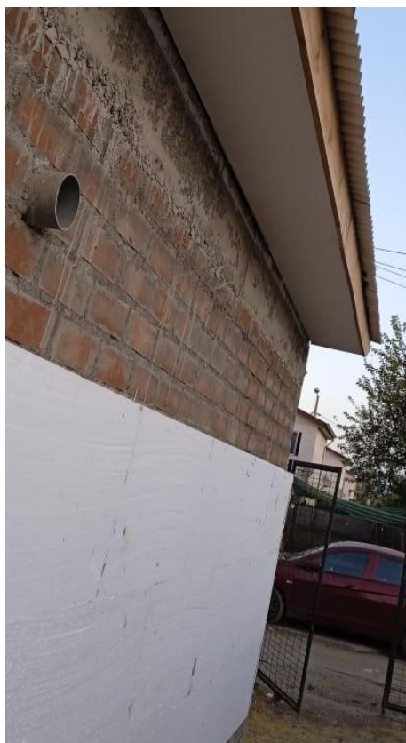
Figura 18. Instalación de planchas EPS en muros por empresa ICUFER Construcciones Ltda.
