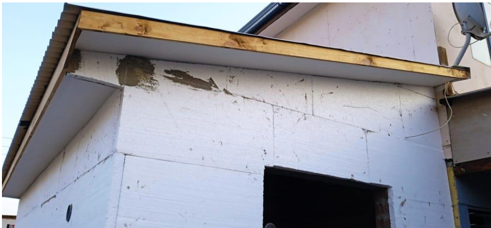
Figura 19. Instalación de planchas en muros y frontones.
