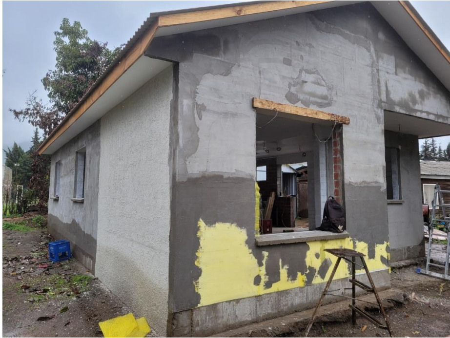
Figura 22. Imagen proceso instalación EIFS por la empresa ICUFER Construcciones Ltda.
