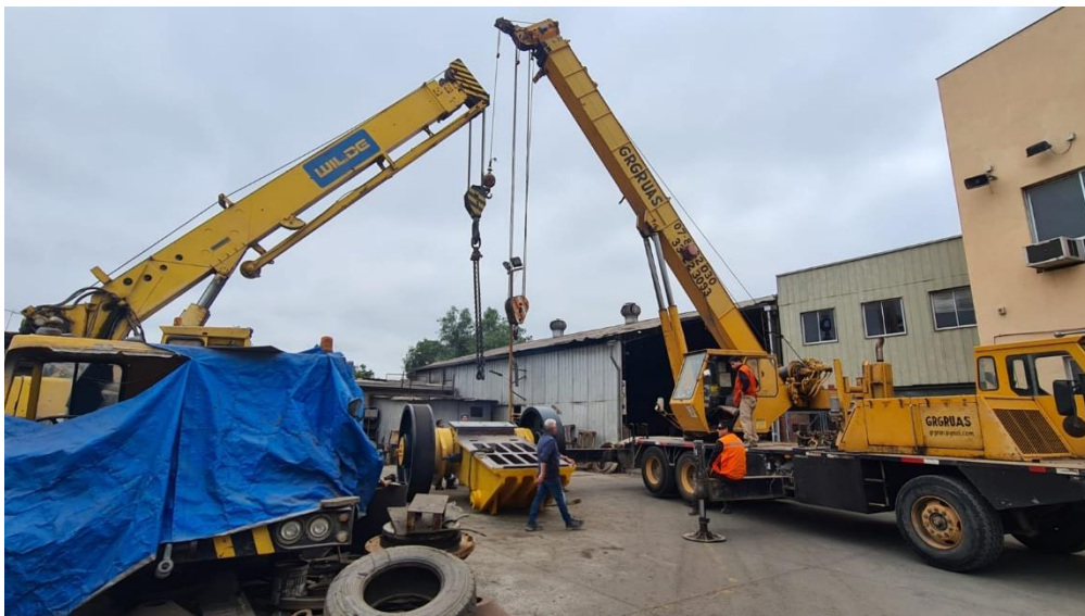
Figura 1-10. Operación de izaje con apoyo de grúa externa
