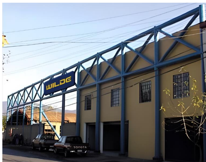
Figura 1-3. Edificio principal de Maestranza Wilde
