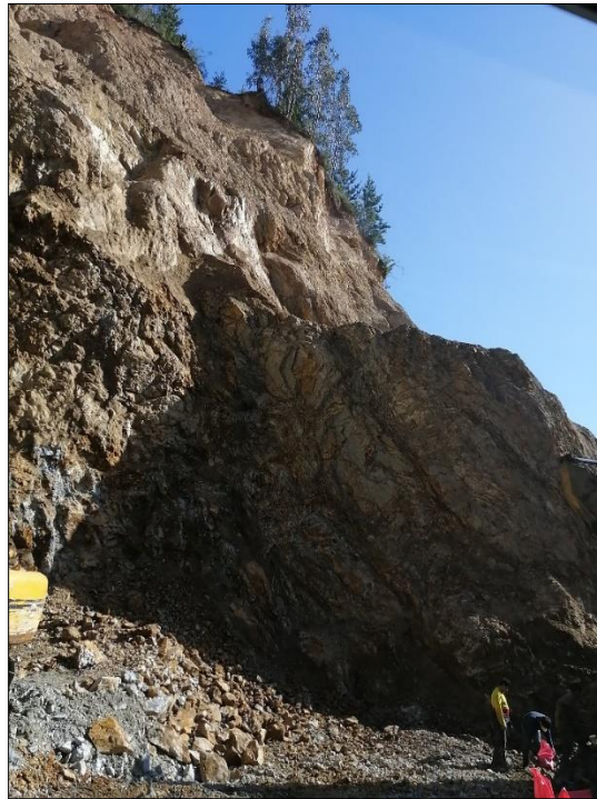
FIGURA 1-3 FOTO DE LA PLANTA DE EXTRACCIÓN
