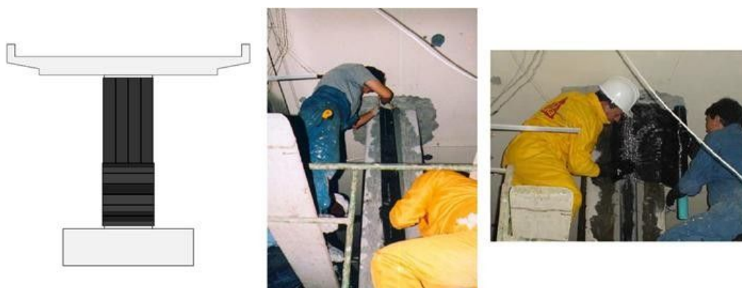
Figura 2.13. Esquema de reforzamiento a flexo-compresión de una columna (fuente: Sika S.A.).
