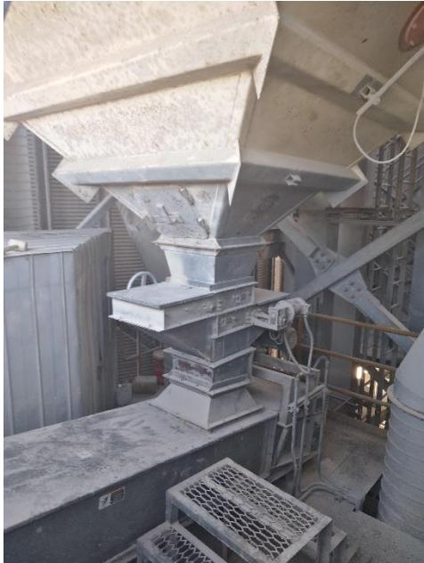
Figura 3-5: Compuerta bajo silo pulmón
