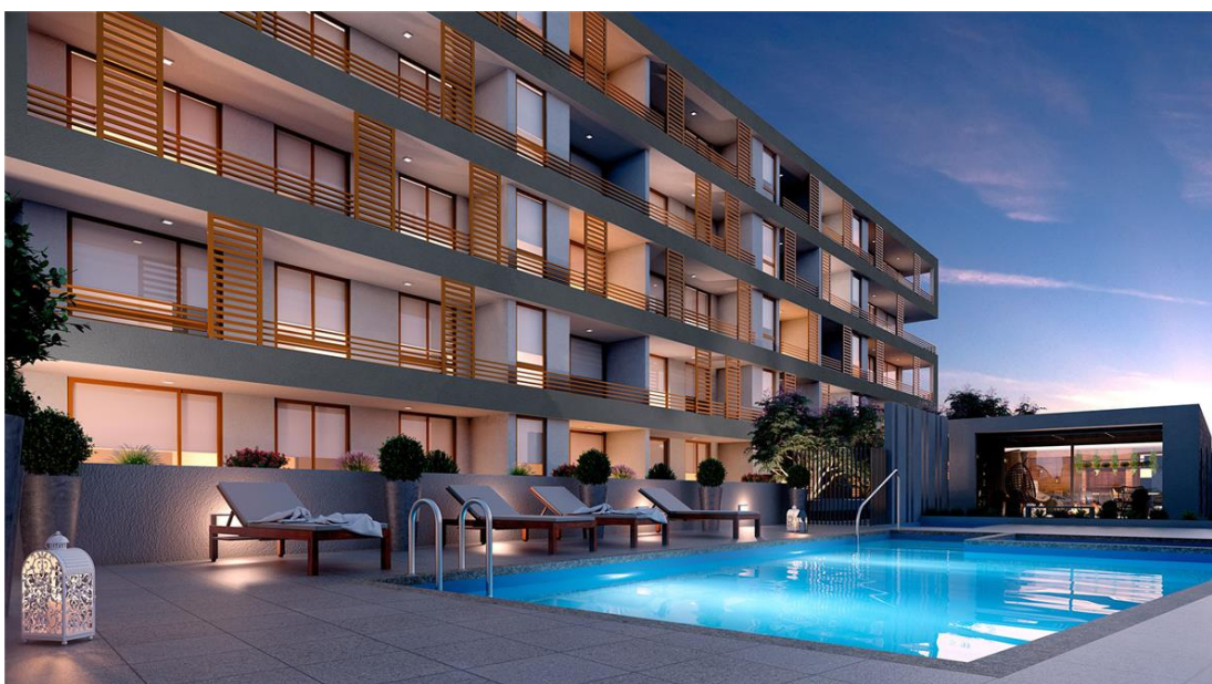
Figura 4-2: Vista Interior General Edificio E.V.H.
