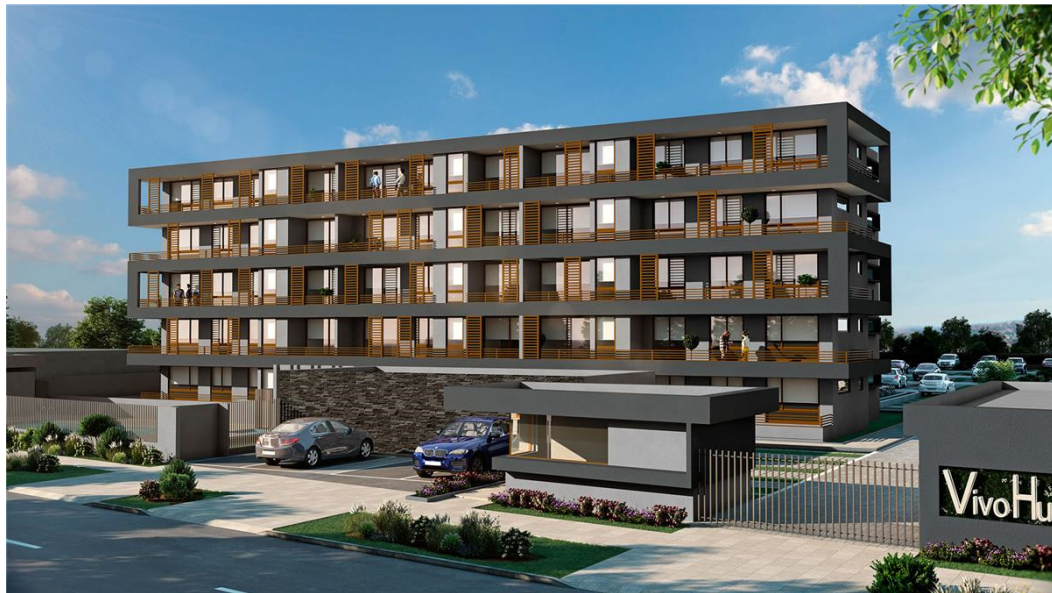
Figura 4-1: Vista Exterior General Edificio E.V.H.
