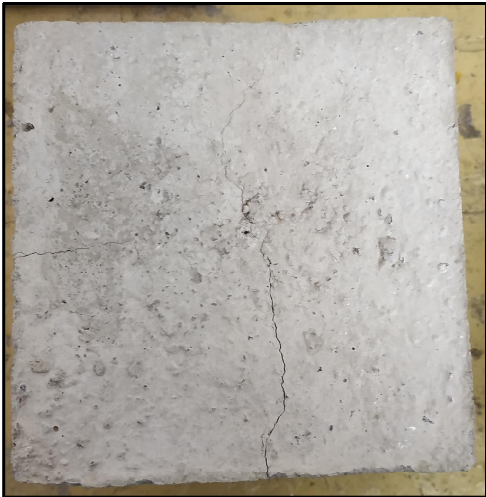
Figura 43: Vista frontal de la unidad de albañilería en disposición horizontal ensayada.
