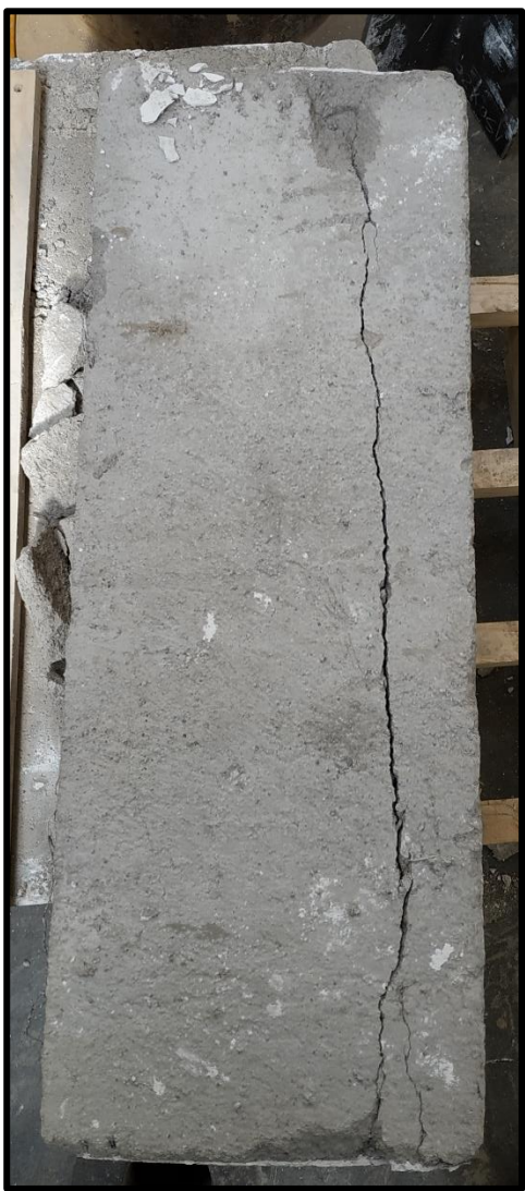
Figura 58: Grietas en prisma de eco-ladrillos en disposición horizontal.
