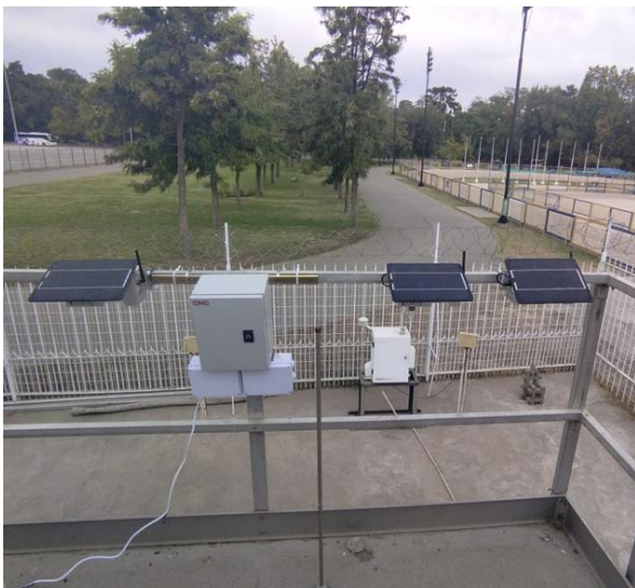
Ilustración 8: Colocación de dispositivos en Estación de Monitoreo del SINCA en Parque O'Higgins.
