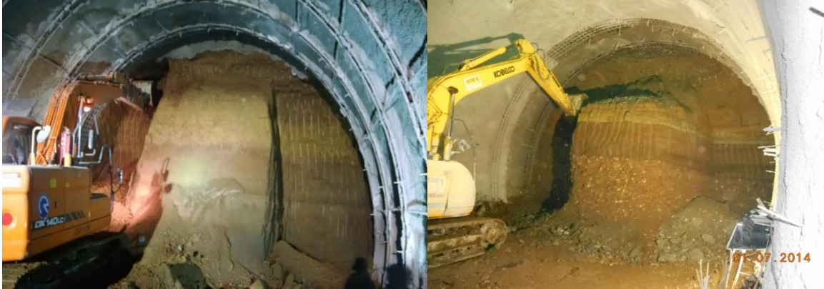
Figura 4: Frente de Excavación
