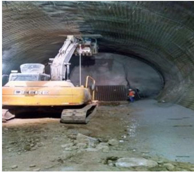
Figura 9: Colocación de Malla Electrosoldada.
