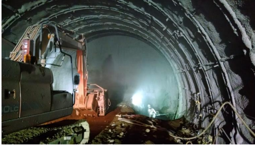
Figura 8: Colocación Revestimiento Primario
