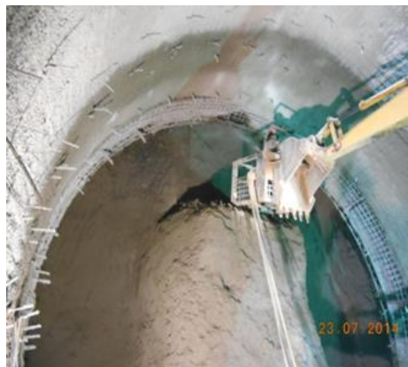
Figura 5: Colocación de Sello (Hormigón Proyectado)
