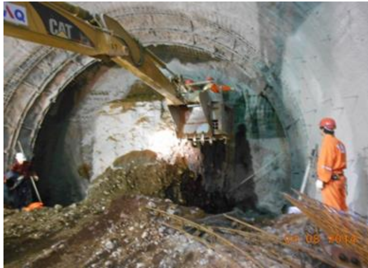
Figura 6: Colocación de Malla electrosoldada
