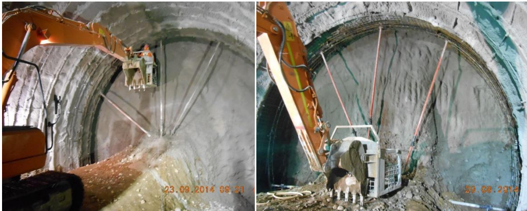
Figura 7: Colocación de marco metálico
