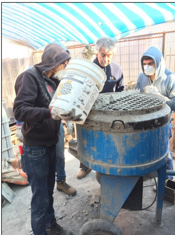
Figura 31. Proceso de hormigonado. Mezcle en betonera (izquierda) y platachado de hormigón (derecha).
