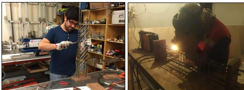
Figura 30. Armado y soldadura de las enfierraduras
