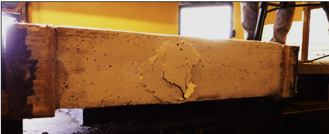
Figura 96. Agrietamiento en zona exterior de la columna a causa del deslizamiento de las barras de refuerzo longitudinal.
