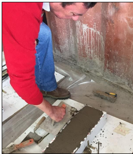
Figura 31. Proceso de hormigonado. Mezcle en betonera (izquierda) y platachado de hormigón (derecha).
