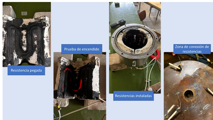
Figura 18: Fases instalación resistencias, elaboración propia
